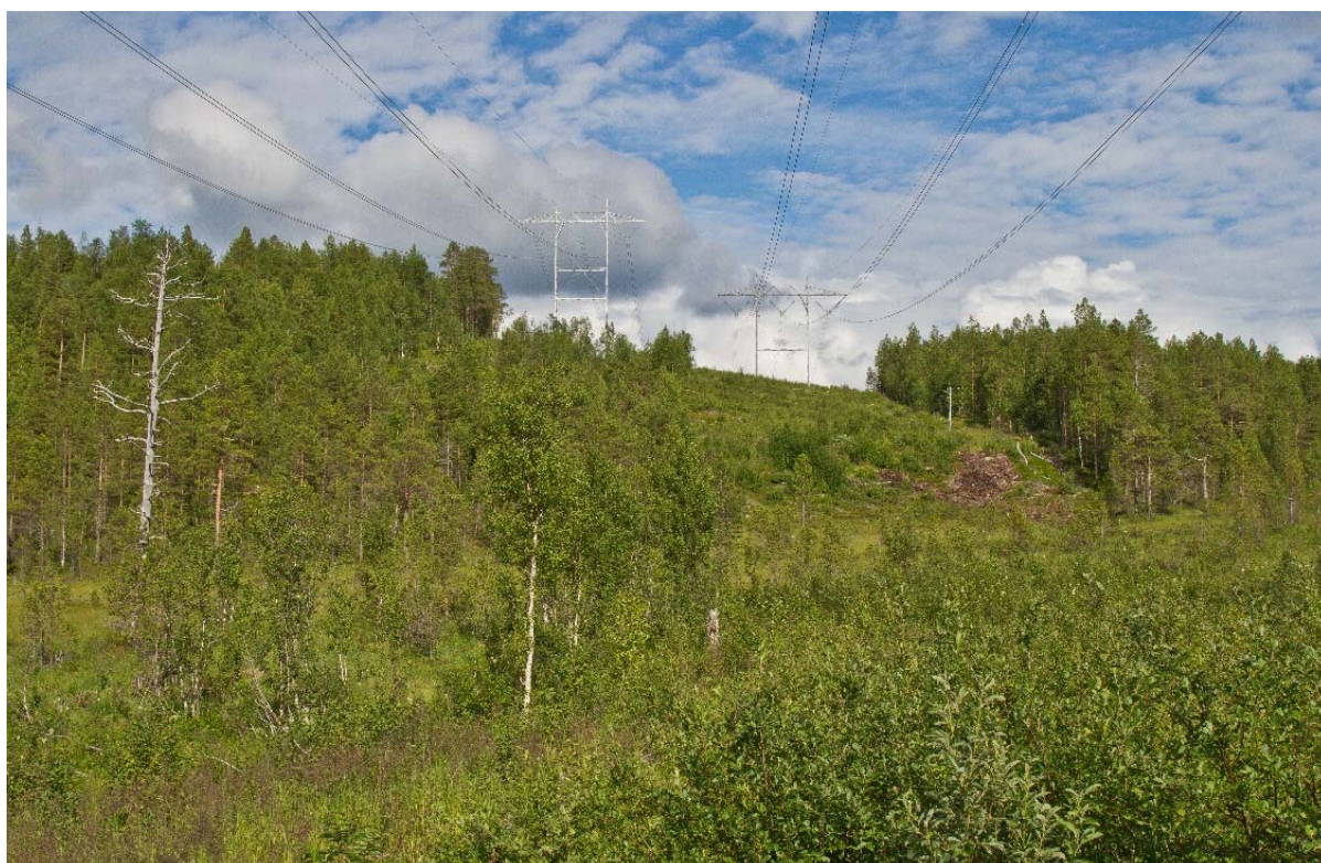
Begrenset skogrydding under ny 420 kV kraftledning Ofoten-Balsfjord til venstre. Vegetasjon som ikke kommer i konflikt med sikkerhetshensyn er bevart og gir et dempet landskapsinntrykk og bedre miljømessig utforming sammenlignet med eksisterende kraftledning til høyre. Foto: Olav Haaverstad/NVE
