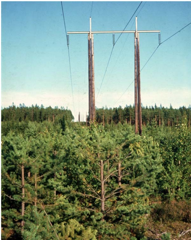
Tilrettelegging for elgbeite ved topping av furuskog i ryddegate, Eidsiva Nett, Løten Allmenning i Hedmark. Foto: Ivar M. Sæveraas/NVE.
