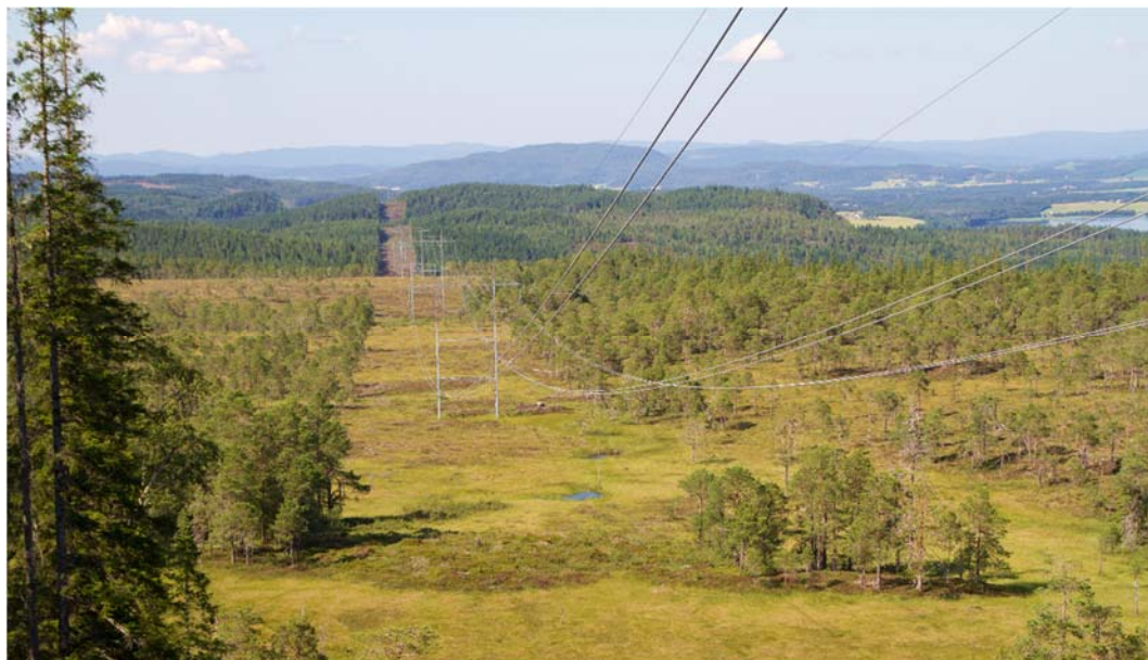
Kraftledningstraséer kan være dominerende "gater" i landskapet. Dersom deler av vegetasjonen spares kan landskapsinntrykket dempes. Foto: Olav Haaverstad/NVE.
