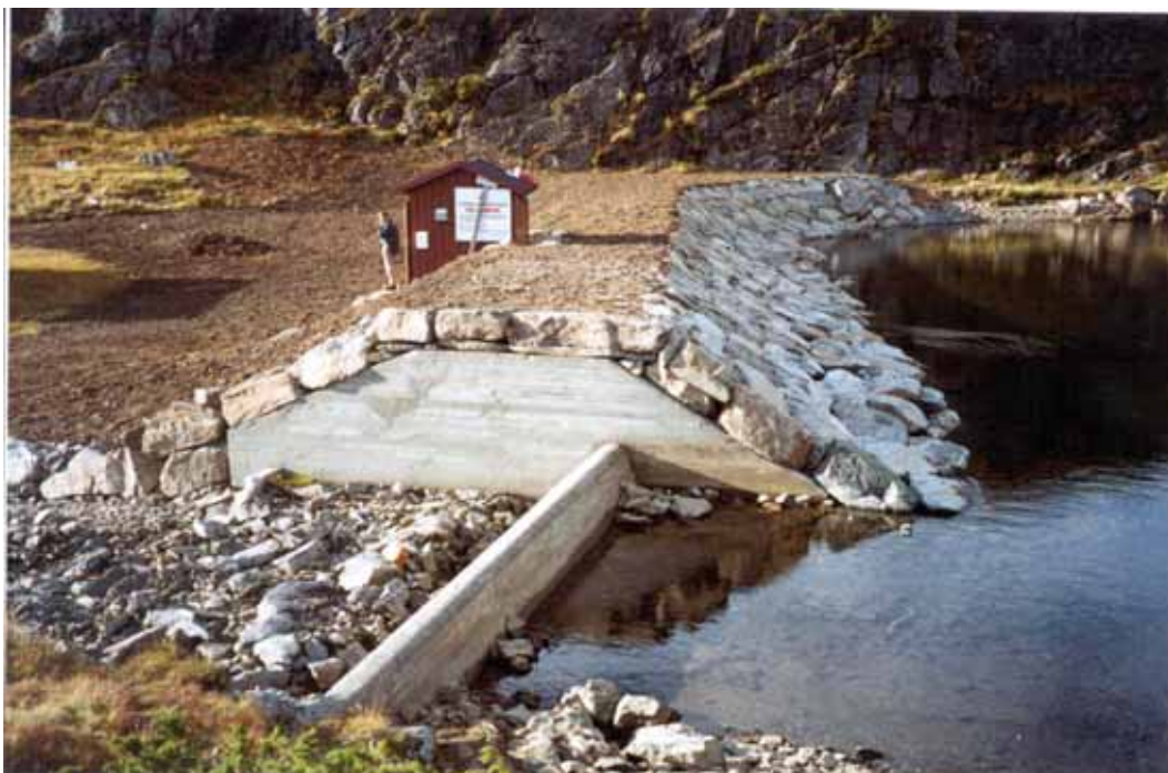
Eksempel på fyllingsdam med flomløpsterskel i betong (Kloppavatn, Molde)
