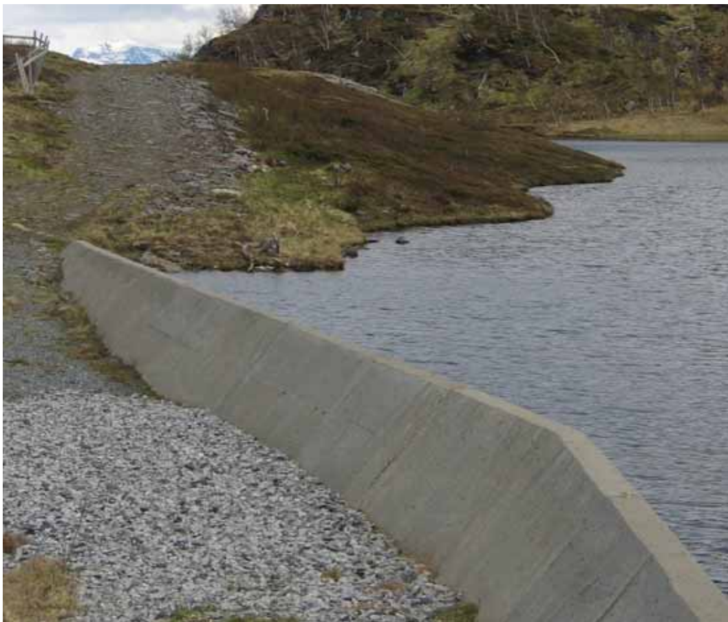
Eksempel på massiv betongdam (Tunga/Røyskattfloget, Nesna)
