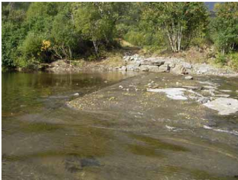
Eksempel på løsmasseterskel (Kvikne)
