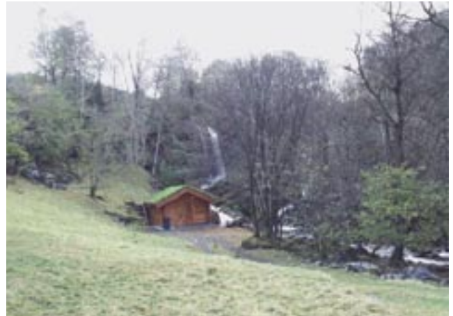
Kraftstasjonsbygning til et minikraftverk bygget i tradisjonelle materialer og god tilpassning til omgivelsene.
