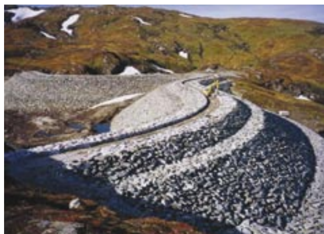
Rehabilitering av dam Kvilesteinsvatn i Vik kommune.
