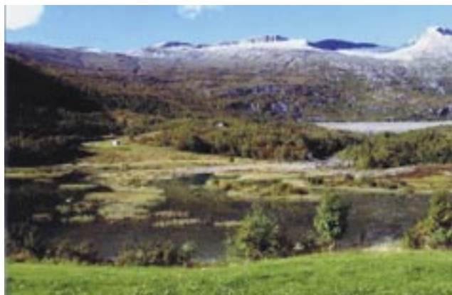
Regulert landskap i Jostedalen. Kontroll med terskelbasseng nedstrøms dam Leirdalen
