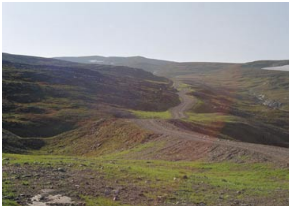
Anleggsveien inn til Kvænangen kraftverk er blitt vesentlig utbedret. Terrenget er arrondert inn til og rundt veien, nakne skjemmen- de veiskuldrer og sår i terrenget er blitt revegetert. Foto: Troms Kraft
