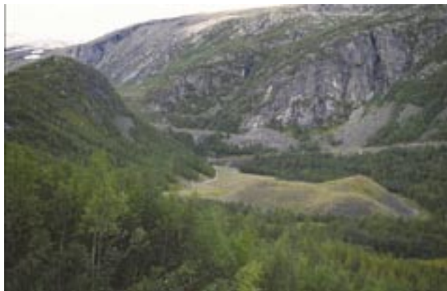
Vegetasjonsetablering dam og tipp Viddalen
