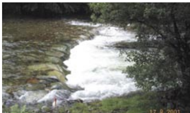
Middels vannføring over terskelkrona gir forholdsvis stor påkjenning på erosjonsgrop
