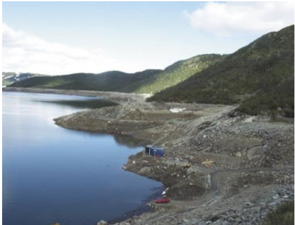
På odden som strekker seg lengst ut i magasinet er det nylig tatt ut ca 11000 m 3 stein i reguleringssonen.
