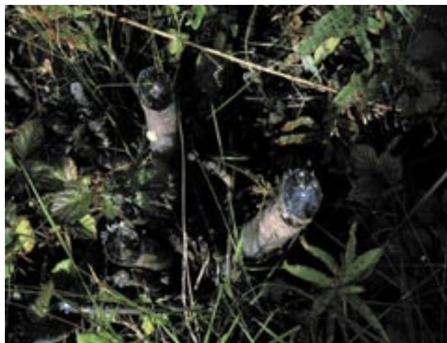
Oppslag av or/vier i tørlagt flomløp. Løpet skal holdes åpent.
