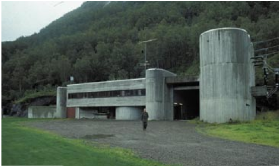
Portalbygget til Sørkjøl kraftverk i Tysfjord med SF6-koblingsanlegg. Dette gir en kompakt løsning i forhold til tradisjonelle friluftsanlegg
