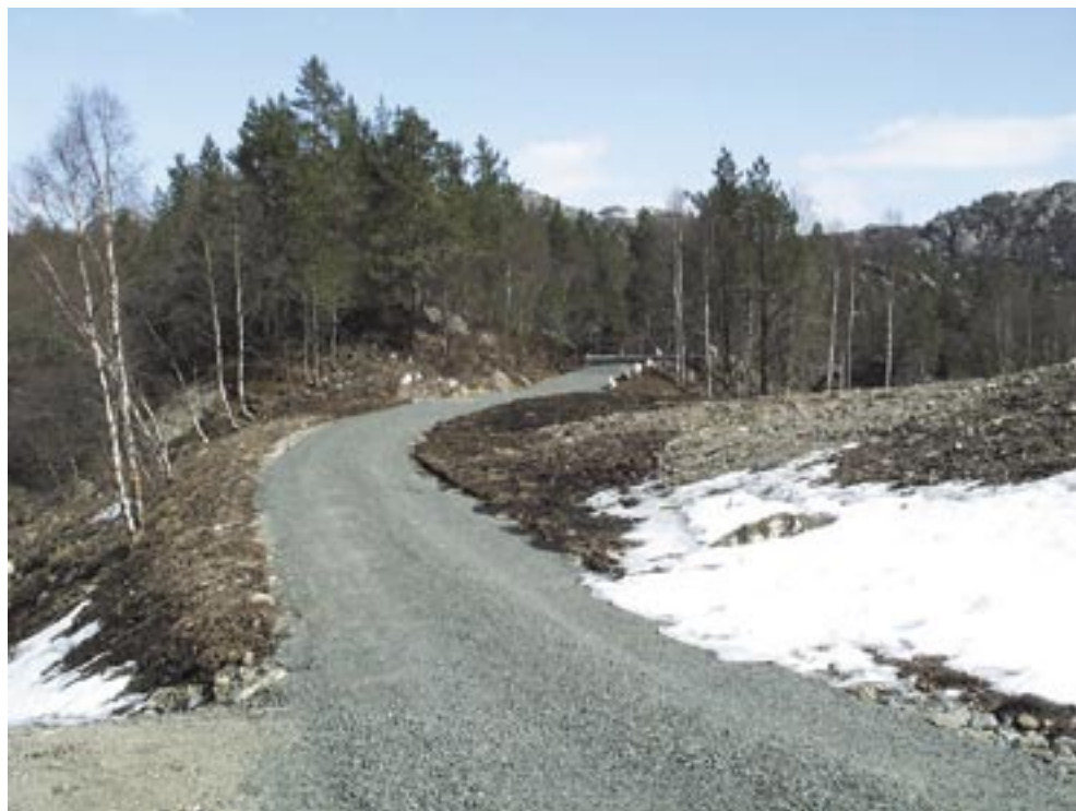
Veilinja følger terrenget og jord er påført veiskulder helt inn til kjørebansens grusdekke. Stabbesteiner er benyttet i stedet for autovern .
