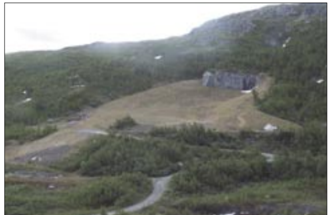
Et gammelt steinbrudd er gitt en landskapsmessig oppgradering. Vrakmasse er lagt inn i bruddet for å redusere inntrykket av bakveggen. I tillegg er det påført et topplag av humusholdige masser som er sådd til med gress. Med etablering av trevegetasjon ville området ytterligere ha glidd inn i omgivelsene. Dette kan oppnås ved innplanting i ettertid.
