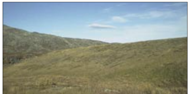
Dam Norddalen kraftverk, Skjomen i Narvik kommune. Revegetert luftside og en vellykket tilpasning til omgivelsene.
