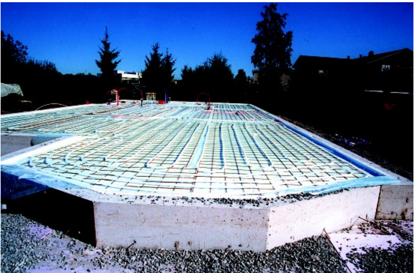
Legging av vannbåren varme i gulv
