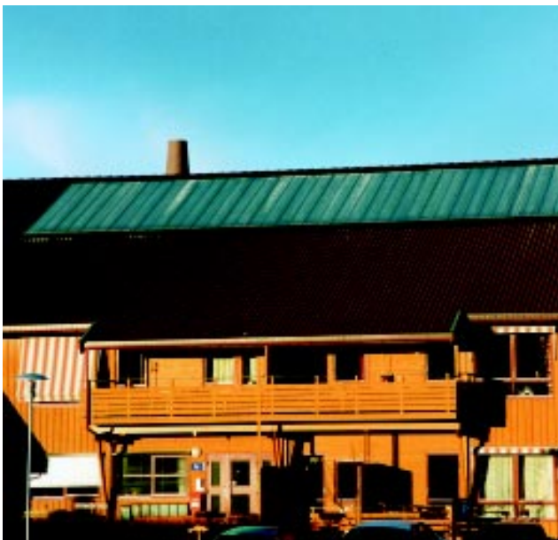
Eksempel på solvarmeanlegg
