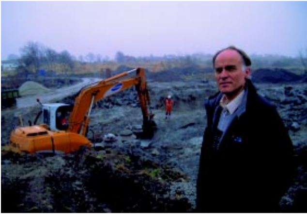
Anleggsarbeiderne er allerede i gang med byggingene av de 216 bollgene på Krosshaug/Loen-feltet på Hundvåg. Prosjektleder for Lyse Energi, Johan Gjemre Olsen, opplyser at alle bollgene er bundet av tilknytningsplikt til fjernvarmeanlegget.
