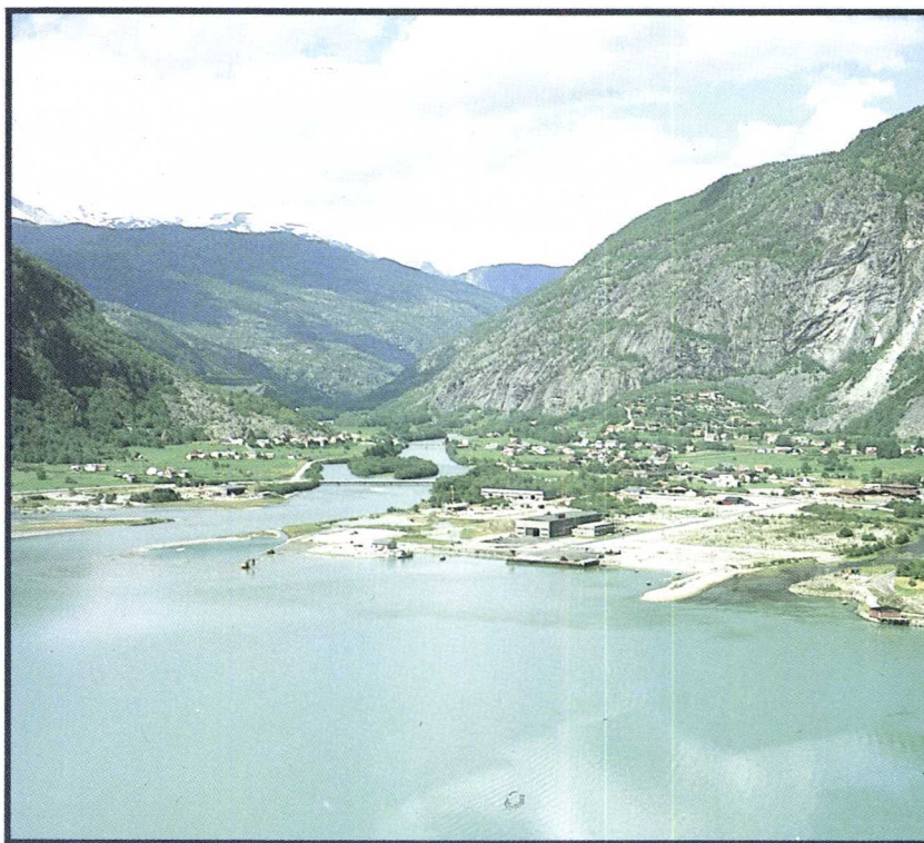
Kommunesentret Gaupne. Mellom elva og dei to industribygga i forkant av biletet kjem Statskraftverka sitt anleggssenter. Her vil det bli oppført kontorbygg, lager og verkstad.
