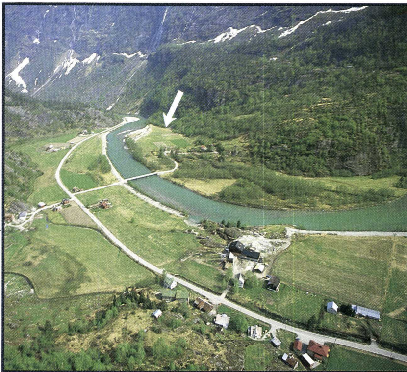
Kraftstasjonsområdet i Myklemyr. Stasjonen skal liggje inne i fjellet, og pila markerer portalen.
