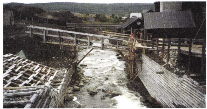
September 2000: Nye forbygninger og installasjoner er på plass. Slagghaugen midt på bildet ble brukt som transportveg for slagg fra Smeltehytta til deponiene på andre sida av elva. Den var felleferdig og måtte bygges opp fra grunnen. Under det demonterte taket til venstre på bildet ligger ruinene etter gammel oppgangssag. Foto: Anders Bjordal
