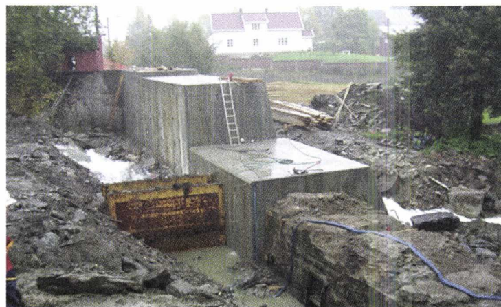
Oktober 2000: Anleggsarbeidene er i full gang.
