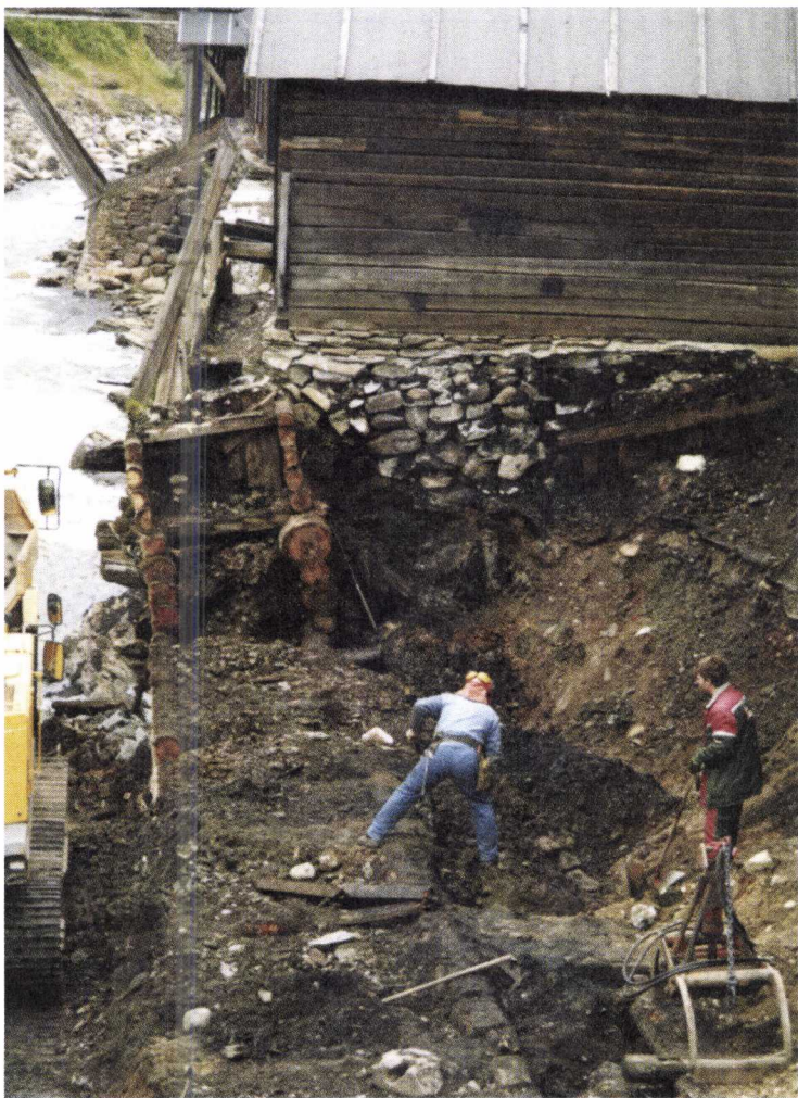
Støttes opp: Oppstøttingen av maskinhuset og fundamentene i bakgrunnen stilte store krav til anleggsarbeidernes årvåkenhet og til god arbeidsplanlegging. Foto: Einar Sæterbø
