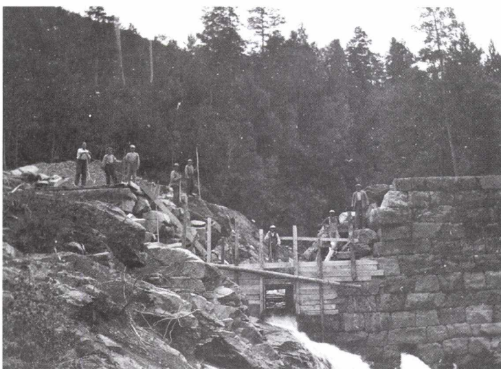
Arbeidskarer: Reparasjon av nedre dam i Gaudøla etter flommen i 1927
