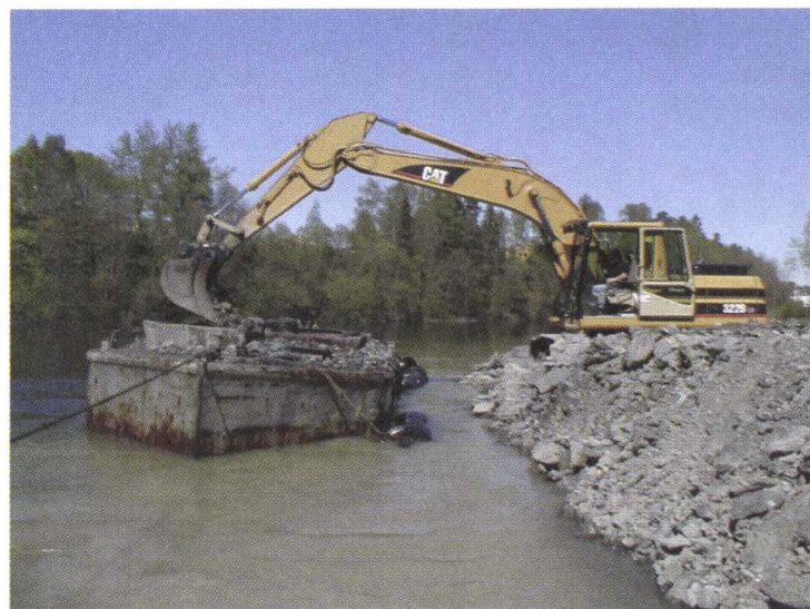
15.000 kubikkmeter stein: Her leses steinen fra mellomlageret på land over til en splitt-lekter. Lekteren frakter steinen ut i elva hvor den dumpes ned i fordypningen. Den delen av fyllmassen som skal plasseres inn på land, legges inn med gravemaskin, som er plassert på ei flåte ved siden av lekteren i elva.
