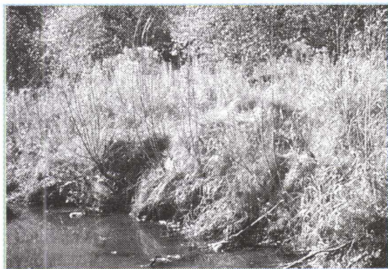
Alternativ erosjonssikring med pilearter. Skokie river nord for Chicago, Illinois, USA.
