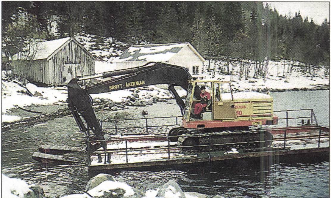
Anleggsmaskinene til NVE Anlegg Region Midt-Norge ble fraktet på flåte til den veiløse Kolsvika.
