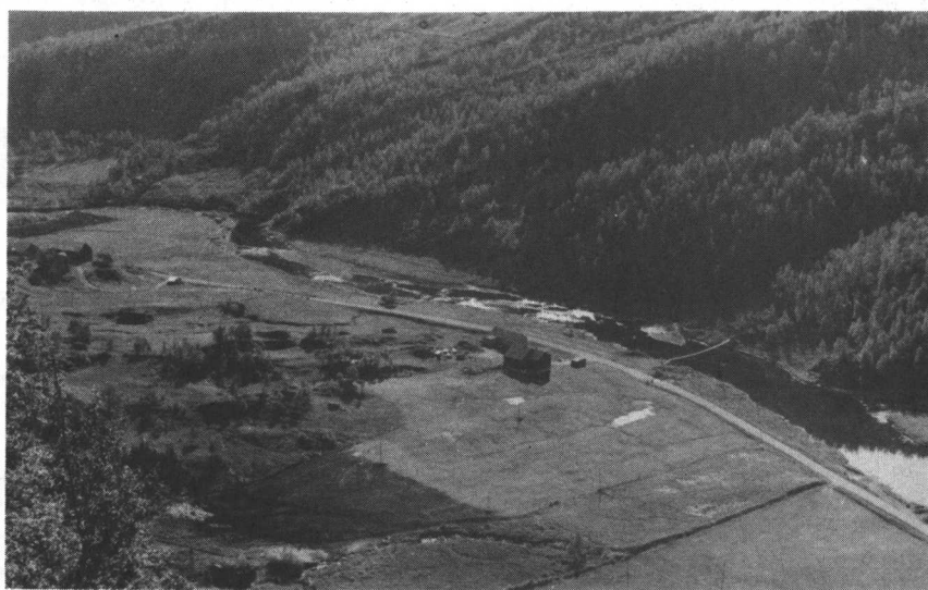
Fig. 5 Sone 4A-4B-5. Terskelbassenget i høyre billedkant. Zone 4A-4B-5. Weir basin to the right.
