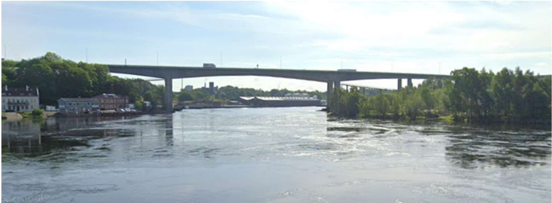
Figur 4: viser Sandesund bru. Foto Google Street View/2024
