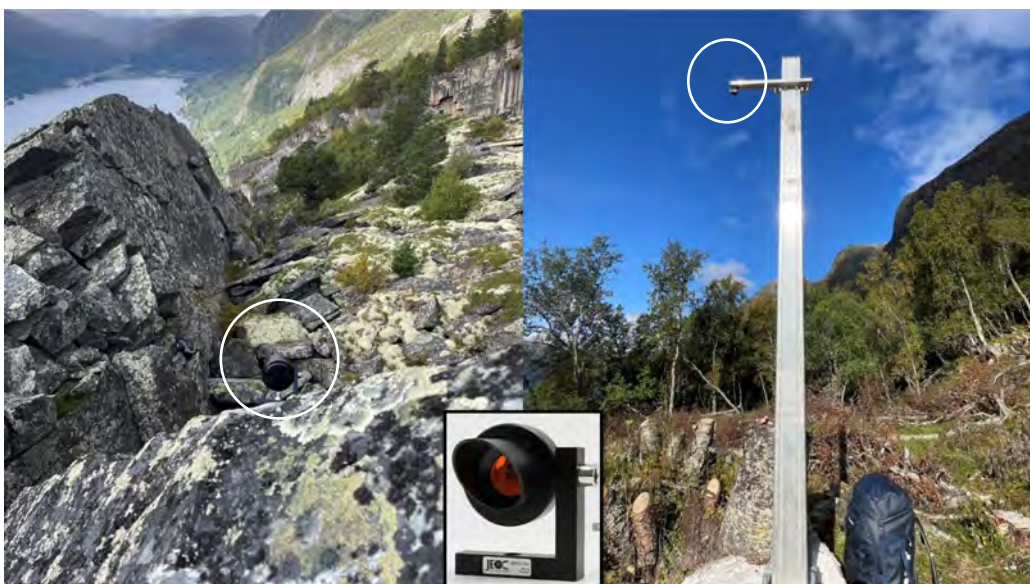
Figur 5: Eksempler på prismer (innfelt) som totalstasjonen måler mot. Prismene (hvite sirkler) er enten montert direkte på blokker (v. bilde, foto: K. Indrevær / NVE), eller på master (h. bilde foto: T. Bergeng / NVE)
