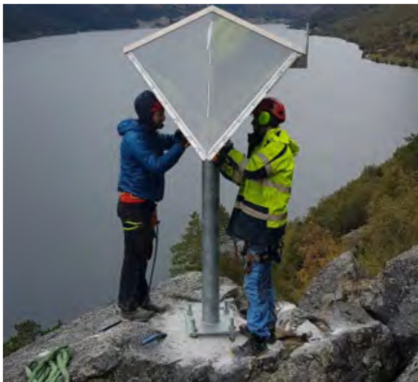
Figur 14: Montering av en hjørnereflektor på «nedre blokk» (SK-SAT-4) på Skutshorn for satellitt-baserte InSAR-målinger. Foto: A. Aspaas / NVE
