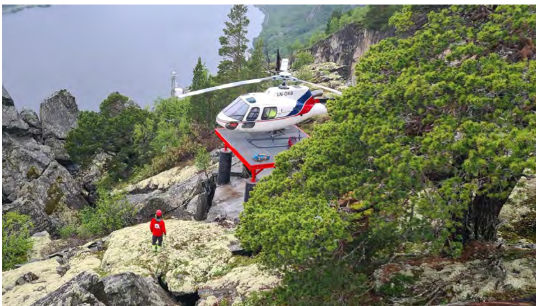
Figur 19: Helikopterlandingsplattformen på «nedre blokk», etablert for tilgang til instrumenteringen for drift og vedlikehold. Foto: K. Indrevær / NVE.
