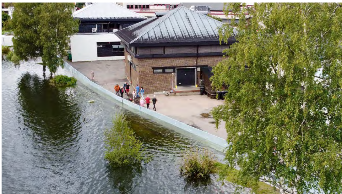
Foto 1 og 2 (under): Mobilt flomvern beskyttet deler av Eidsvoll sentrum under Hans. Her vises flom ved Sundet aktivitetspark. Overvannn ble pumpet ut over flomvernet. Foto: Haawal
