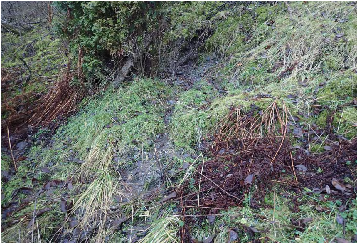
Figur 17: Oppkomme og bevegelse i massene i nedre del av terrasseskråningen over bebyggelsen på Peøya.
