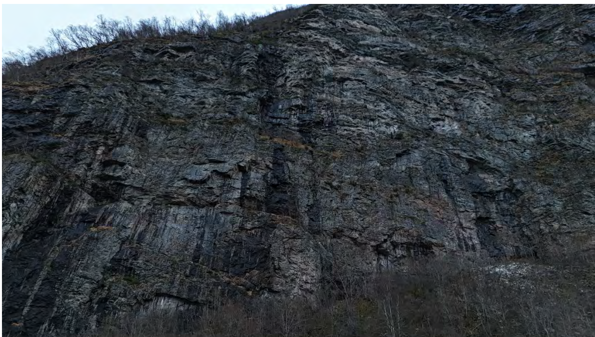
Figur 4: Nedre del av fjellsiden nord for Hushamran.
