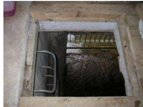
Figur 8-21: Luke ned til kulvert
