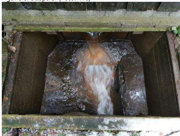
Figur 8-7: Utløp (Foto: NVE)
