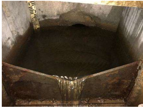
Figur 8-78: V-profil og innløp (Foto: NVE)
