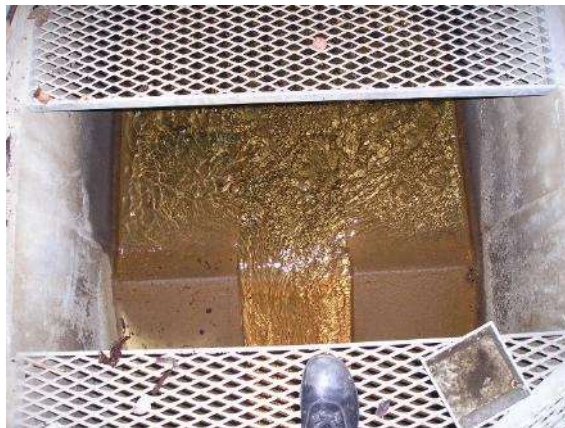
Figur 8-63: Crump-overløp 1983-2002 (Foto: NVE)
