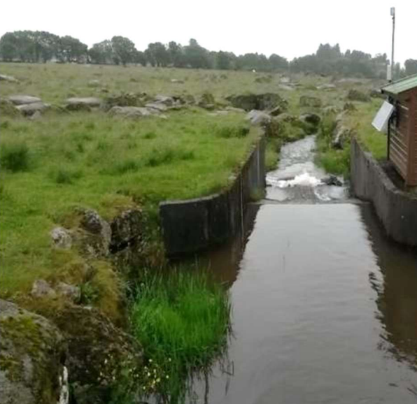
Figur 8-50: Crump-overløp og utløpskanal (Foto: NVE)
