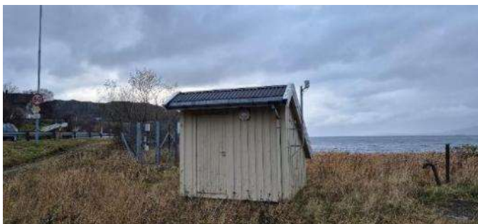
Figur 8-120: Stasjonsplassering (Foto: NVE)
