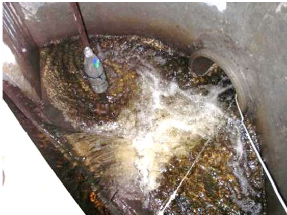
Figur 8-77: V-profil og utløp (Foto: NVE)
