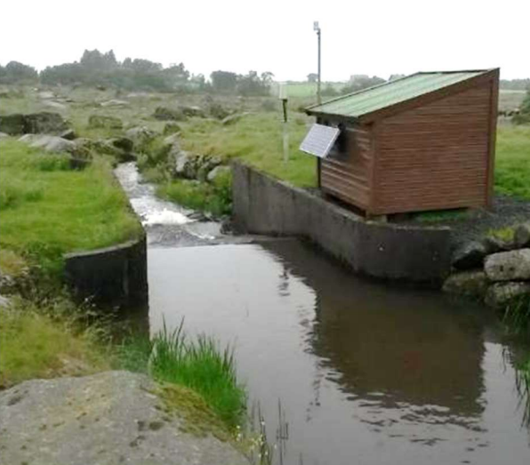
Figur 8-52: Stasjonsbygg med nedbørsmåler og temperatursensor (Foto: NVE)
