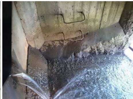
Figur 8-19: Utløp (Foto: NVE)
