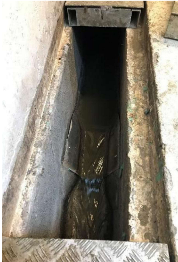
Figur 8-105: Spillvannsrenne på Risvolla (Palmer-Bowlus) (Foto: NVE)
