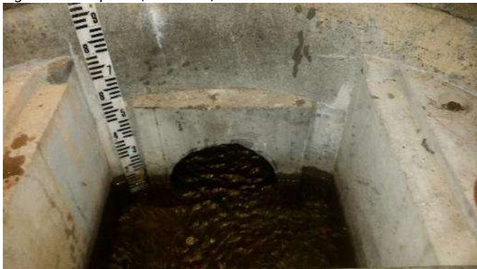
Figur 8-118: Tilløpsrør og skala (Foto: NVE)
