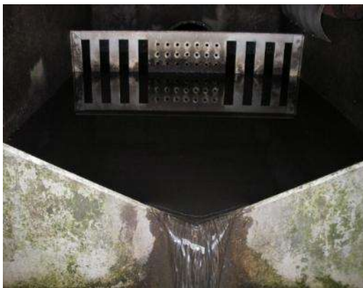
Figur 8-36: V-profil og strømdemper (Foto: NVE)
