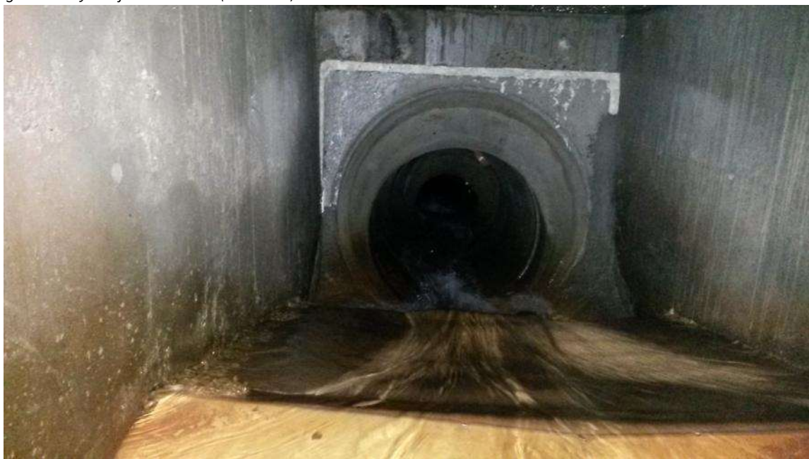
Figur 8-66: Større konet utløp etter 2013 (Foto: NVE)
