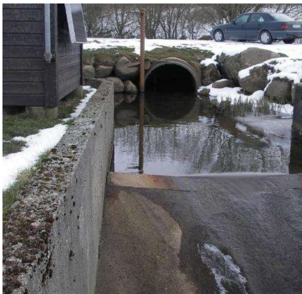
Figur 8-49: Tilløpsrør og Crump-overløp (Foto: NVE)
