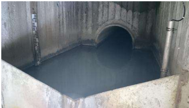
Figur 8-18: Tilløp, kulvert og profil (Foto: NVE)
