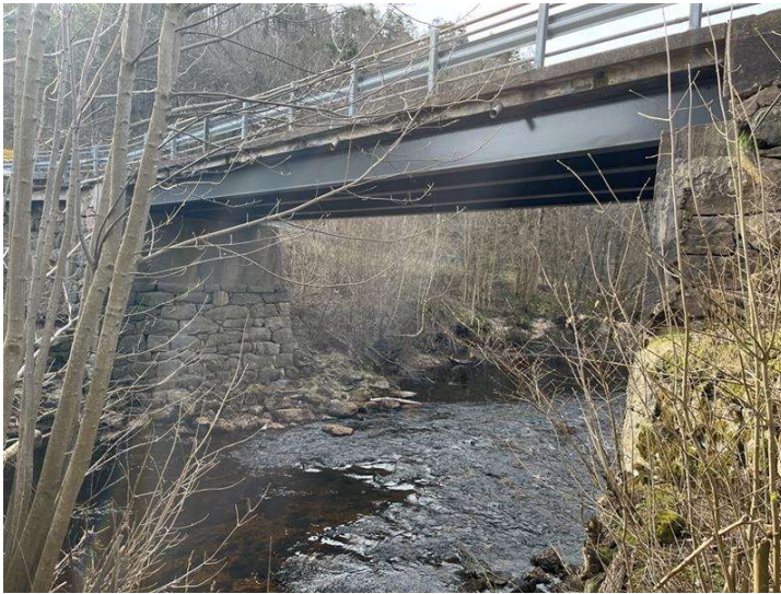
Figur 14: Bildet viser Tofteland bru. Foto Ole Fjellstad Holt/2025
