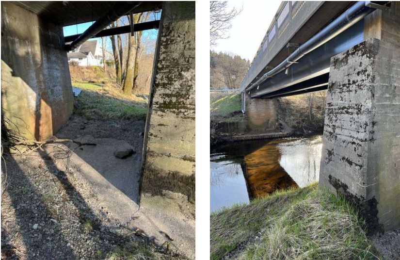
Figur 8: Bildene viser Nodeland bru. Sett fra oppstrøms viser venstre bilde venstre løp, høyre bilde høyre løp. Foto Ole Fjellstad Holt/2025
