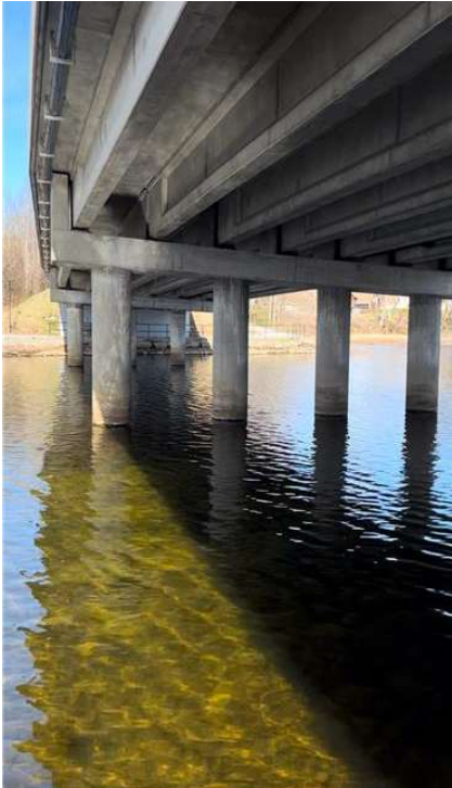
Figur 18: viser Åros bru. Foto Ole Fjellstad Holt/2025
