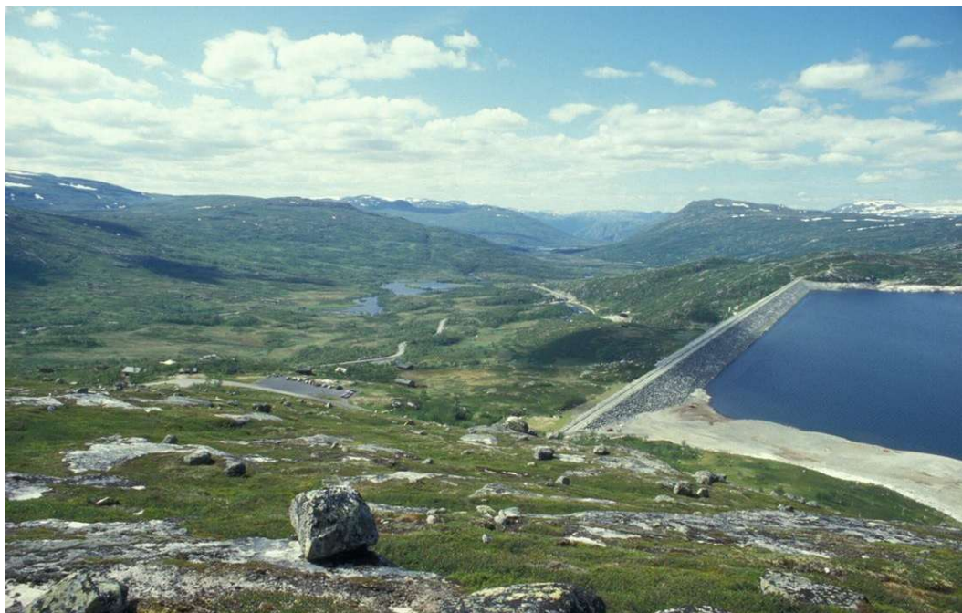
Figur 6 Sysendammen, som regulerer Sysenvatnet, er en av Norges største steinfyllingsdammer og har en samlet lengde på 1160 meter (Foto: NVE).
