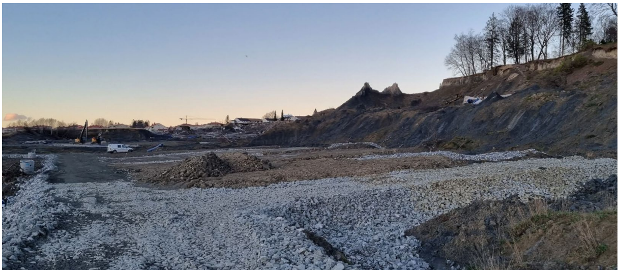
Figur 32b. Nærbilde av adkomst-/drensveiene ved Holmen. Kult (20/120 mm) ble pakket i duk, dekket av leire/jord og utgjør en permanent, lukket drenering av skråningene. Veien lengst til venstre på bildet ble bygget om til en samlegrøft for både lukket drenering og overflateavrenning, etter prinsippet vist i figur 27c.
