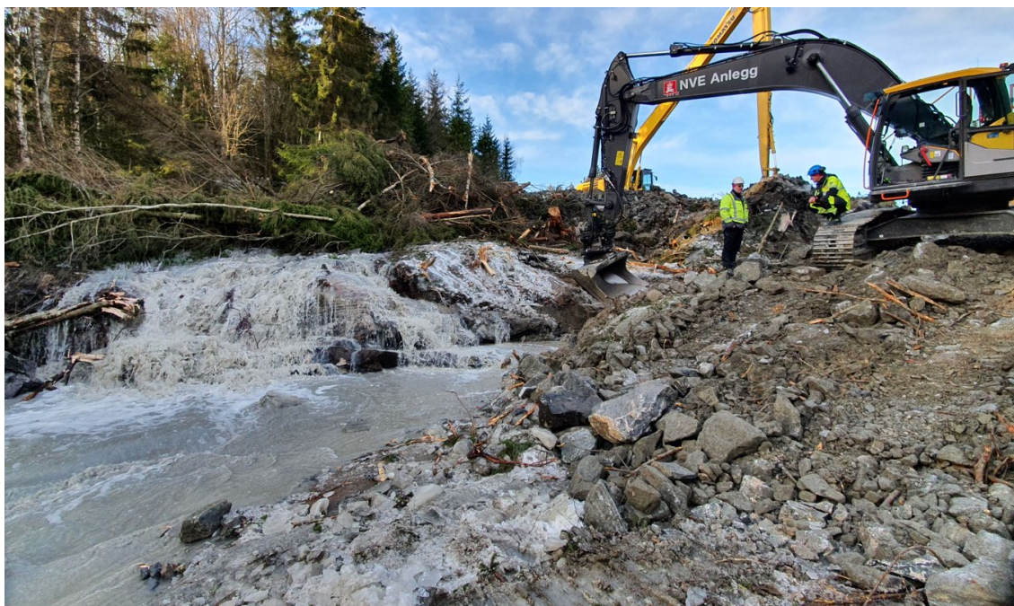
Figur 29. Fronten av skredmassene ved Hval. Første del av arbeidet med etablering av erosjonssikring av fronten.
