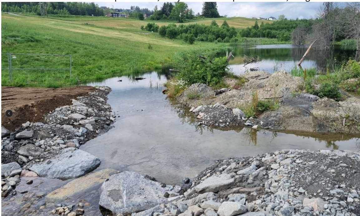
Figur 33. Terskel og erosjonssikret utløp fra «dammen», til høyre på bildet. Bekkeløpet til Tistilbekken fortsetter videre ned til venstre på bildet.
