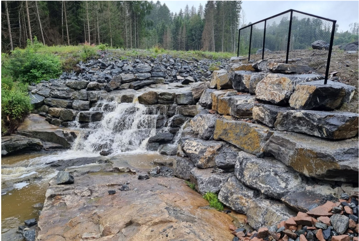
Figur 30. Ferdig plastringsmur sikrer fronten av skredmassene. Ferdig erosjonssikret elveløp i toppen av skredmassene og videre innover i motstrøms retning.
