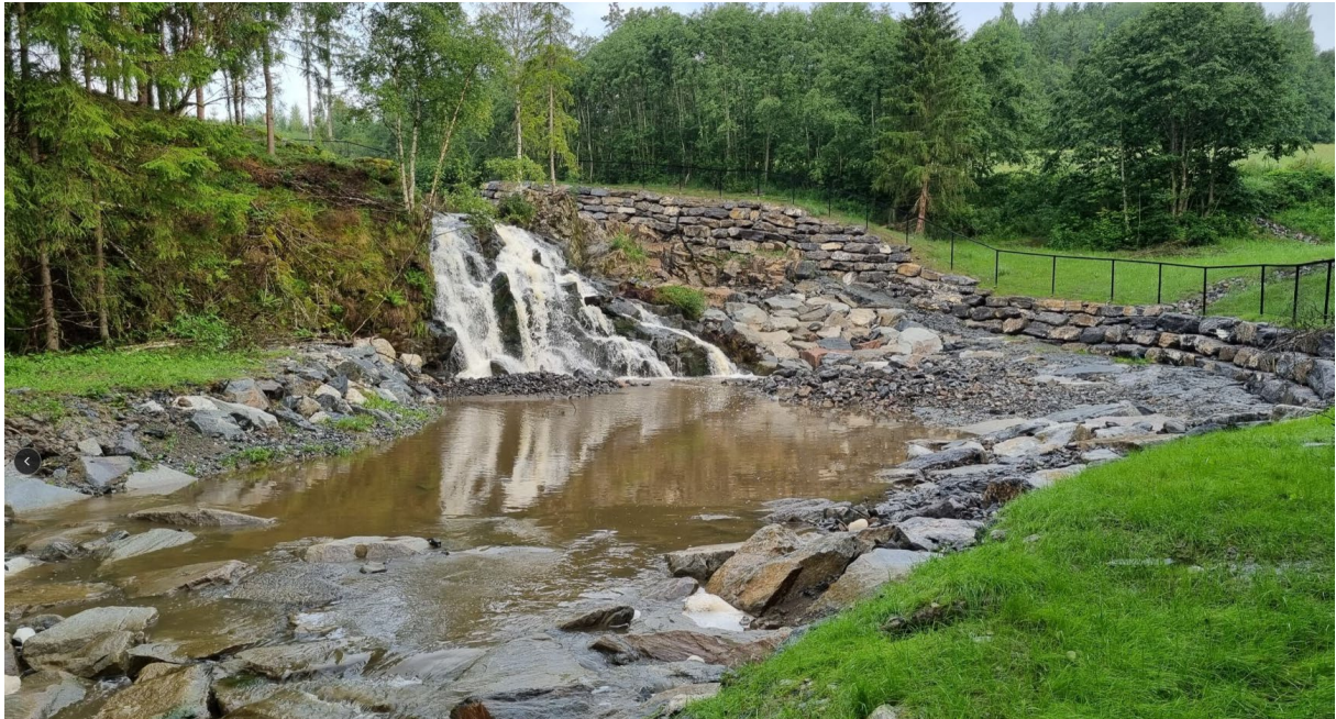
Figur 31. Ferdig erosjonssikret strekning nedstrøms fossen. Plastringsmur på venstre elveside (til høyre på bildet) samt bunnplastring i og nedstrøms fossen. Ordnet steinlag til venstre i bildet. Topp av løsmasseterskel nederst på bildet, som overgang til urørt elvestrekning lengre nedstrøms.
