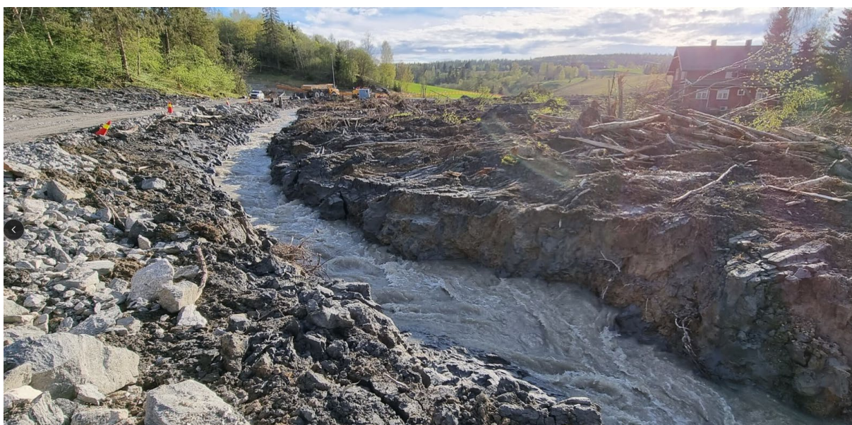
Figur 27b. Ferdig uttrauet pilotkanal i skredmassene nedstrøms fv.120. Skredmassene lagt til side i lave ranker i tilstrekkelig avstand fra elveløpet.
