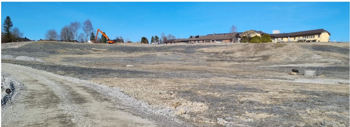
Figur 18a og 18b. Ferdig gjennomført motfylling og terrengarronding i Nordgropa. Figur 18b har omtrent samme utsnitt som figur 17b.
