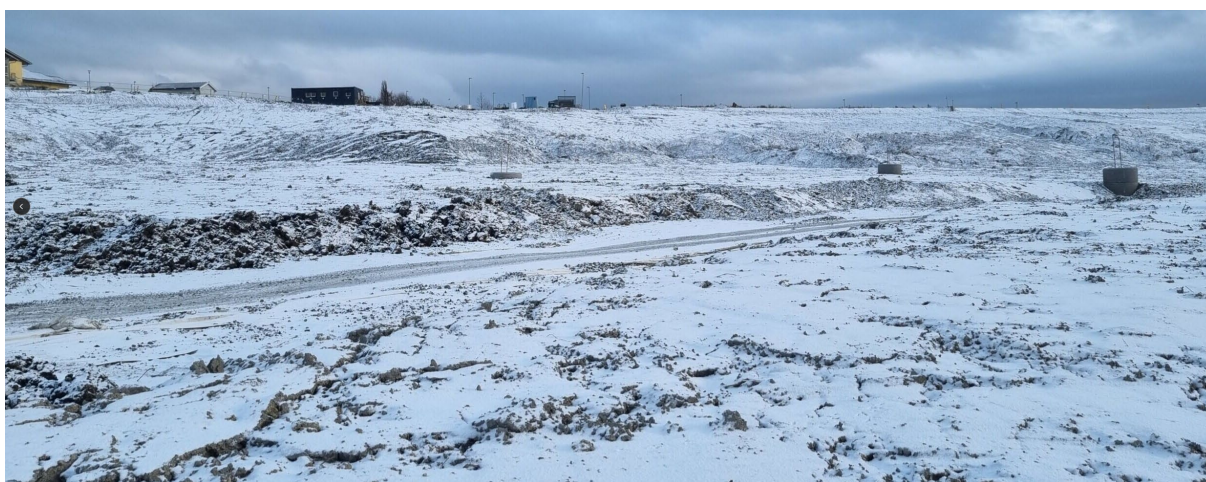
Figur 16a og 16b. Ferdig utlagte oppfyllingsmasser i skredgropa. Forsenkning i midten av gropa er anleggsveier for transport av masser samt drenering av overflatevann. På dronebildet (16a) er drengslaget med installerte vertikaldren synlig, innerst i Nordgropa. På figur 16b kan Gjerdrum bo- og behandlingssenter skimtes øverst til venstre på bildet.
