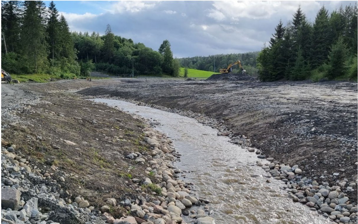
Figur 27c. Ferdig dimensjonert og erosjonssikret elveløp. Vekstmasser og elvestein dekker erosjonssikringen (sprengstein). Bilde tatt sommeren 2023.
