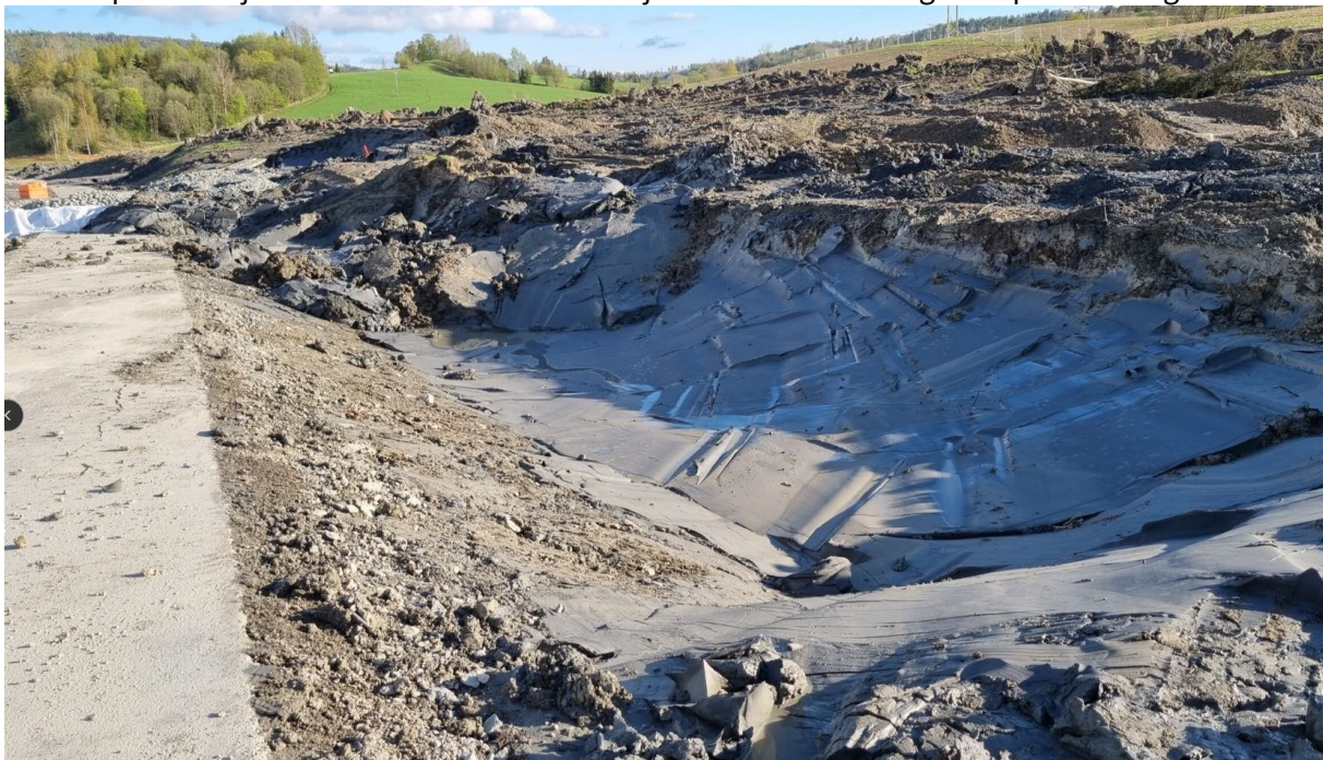
Figur 24a. Uttrauing av nytt bekkeløp for Tistilbekken langs fv.120 (til venstre i bildet).
