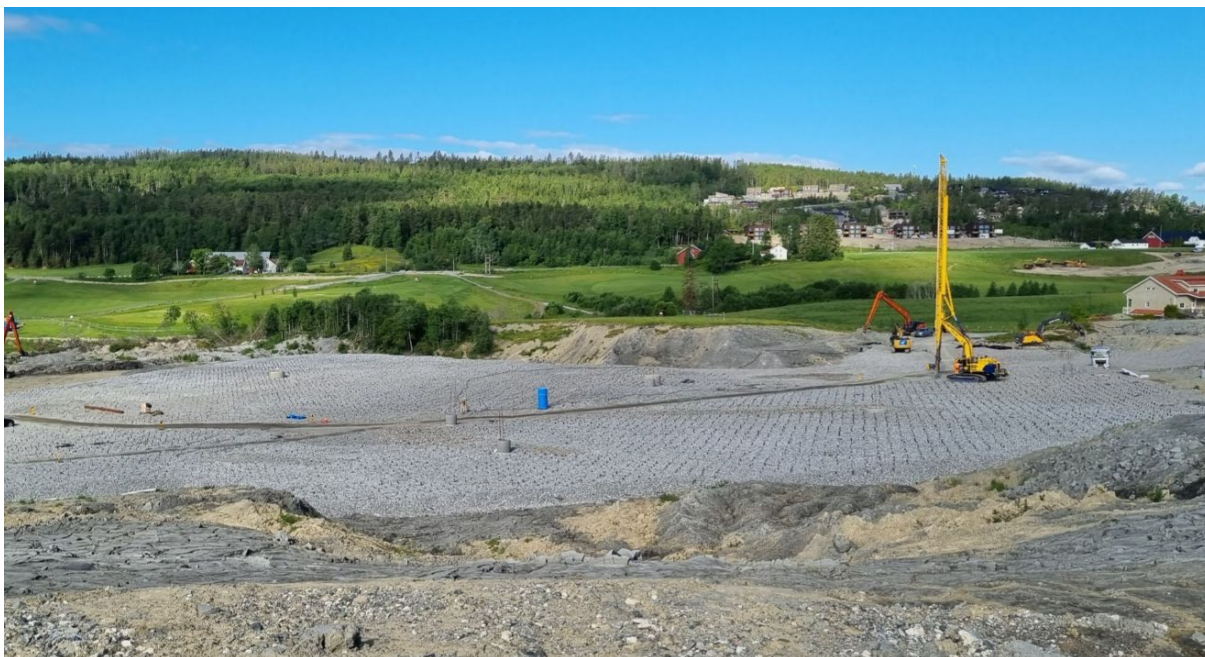
Figur 22. Etablering av vertikaldrenering. Rutenettet med ferdig installerte vertikaldren er godt synlig i hele området til venstre for riggen, som svarte linjer på den lysegrå overflaten av drenslaget.
