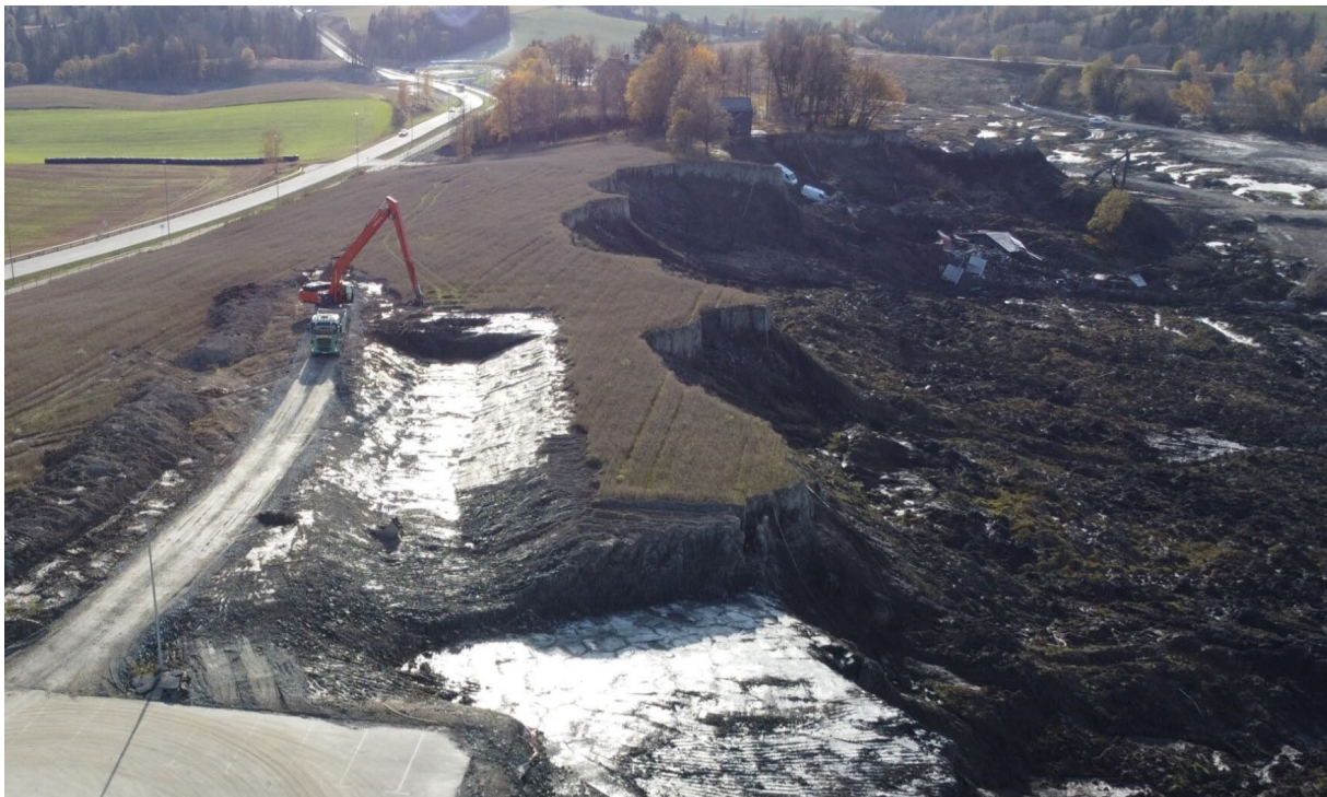
Figur 13. Etablering av avlastningsgrøft som kompensasjon for vekten av anleggsutstyret. I neste fase flyttes utstyret nærmere skråningskanten som da kan avlastes. Massene avsatt ved tidligere etterskred er synlige lengst til høyre på bildet.
