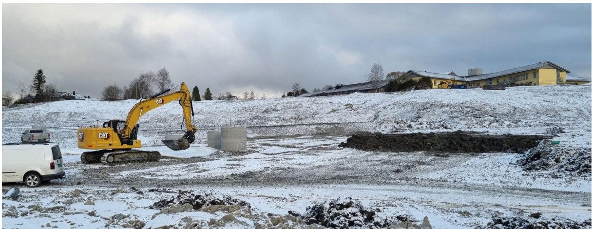
Figur 17a og 17b. Utlegging av nederste del av motfyllingen. På dronebildet (17a) er den hvite separasjonsduken mellom drenslag/vertikaldren og kommende motfylling synlig.
