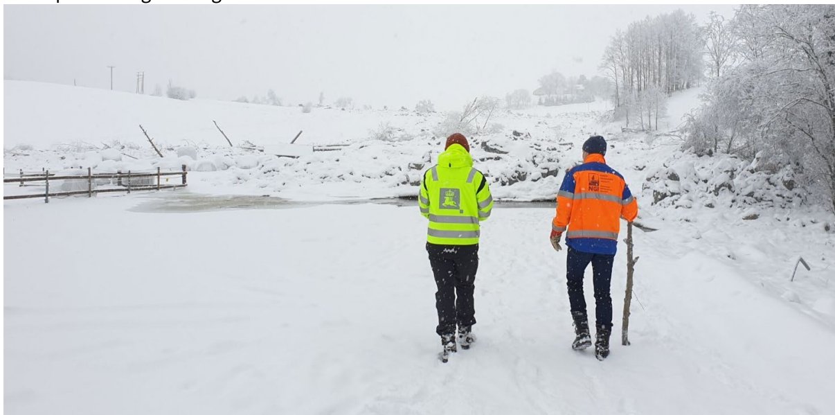
Figur 26. Området der fv.120 krysser Tangeelva, januar 2021. Skredmasser har fylt opp elveløp og kulvert samt fv.120.
