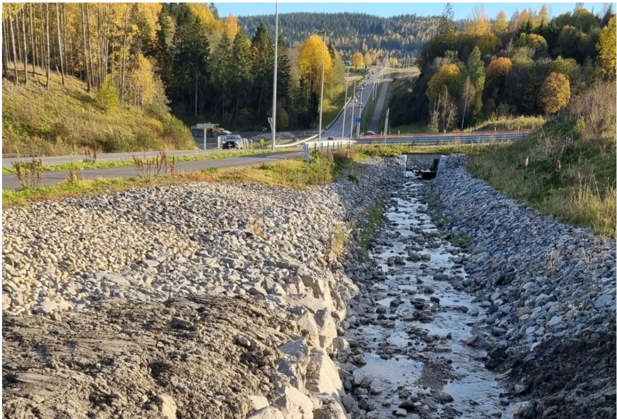
Figur 24b. Ferdig erosjonssikret bekkeløp på omtrent samme strekning som vist på figur 24a, før utlegging av vekstjord, fv.120 til venstre på bildet.
