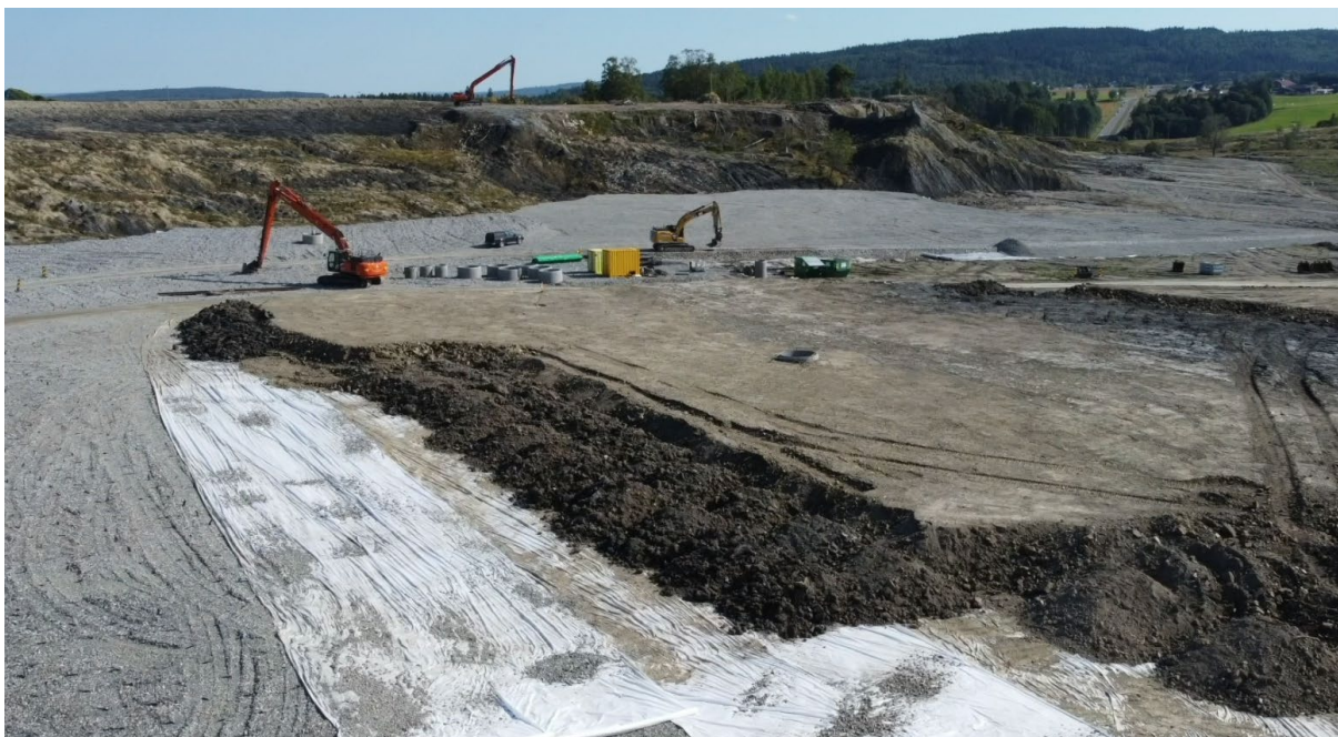
Figur 21. Utlegging av masser fra avlastningen ved Østkanten (bakerste gravemaskin på bildet) over drenslaget med installerte vertikaldren. Den hvite separasjonsduken mellom oppfyllingsmasser og drenslag er også synlig.
