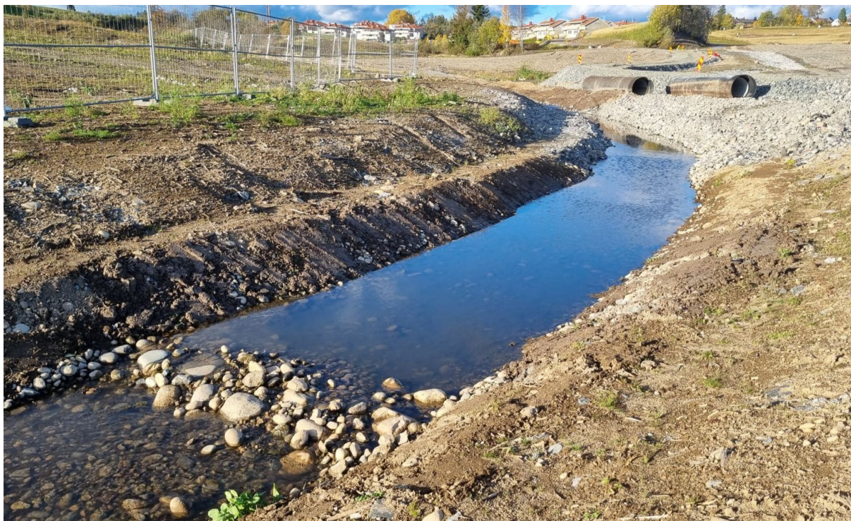
Figur 34. Eksempel på strekning med ferdig erosjonssikret bekkeløp for Tistilbekken, rett etter utlegging av vekstjord og kulestein til å dekke sprengsteinen. Tilsåing og annen vegetasjonsetablering gjenstår fortsatt på dette bildet.
