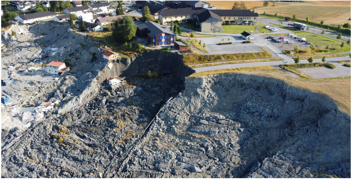
Figur 12a og 12b. Den bratte skredkanten langs østre og nordre del av skredgropa, med de nesten loddrette kantene i toppen av skråningen. Bildene tatt rett før oppstart av anleggsarbeidene i august 2021.
