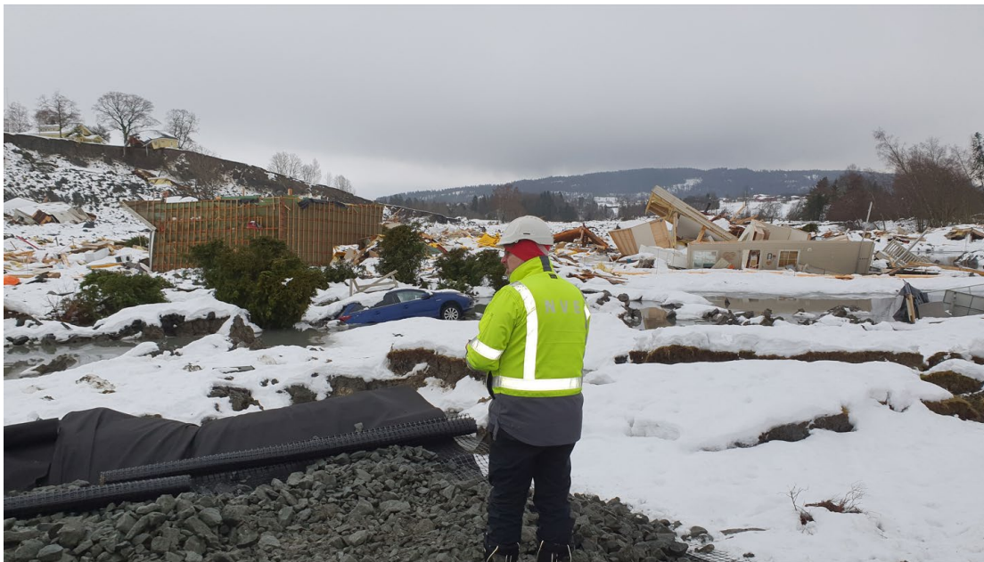
Figur 07. Bilde fra etablering av adkomstveien oppå skredmasser inn til selve skredområdet.
