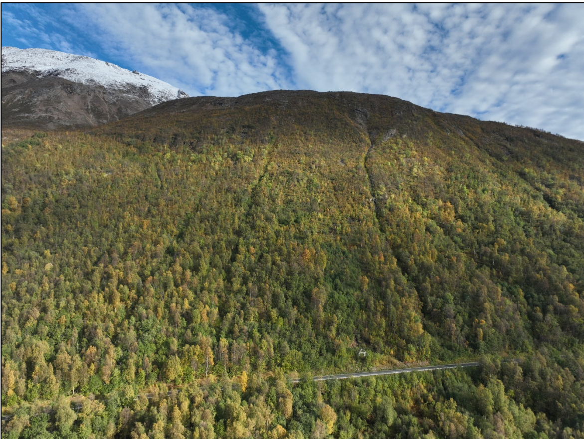
Figur 13 Fjellskråningen med gamle E6 synlig som avskjærer skredbanene
