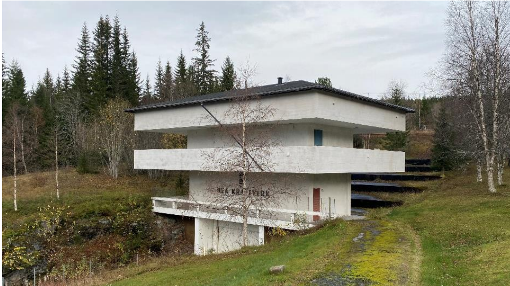
Figur 12 Dagens portalbygg Nea. Foto: NVE/hmn, 2021.
