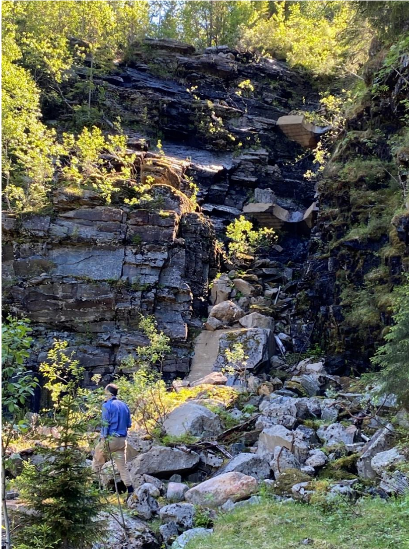
Figur 9 Rester etter fundamentering av kraftstasjonen og rørgaten ved Storfossen. Foto: NVE/hmn, 2021.
