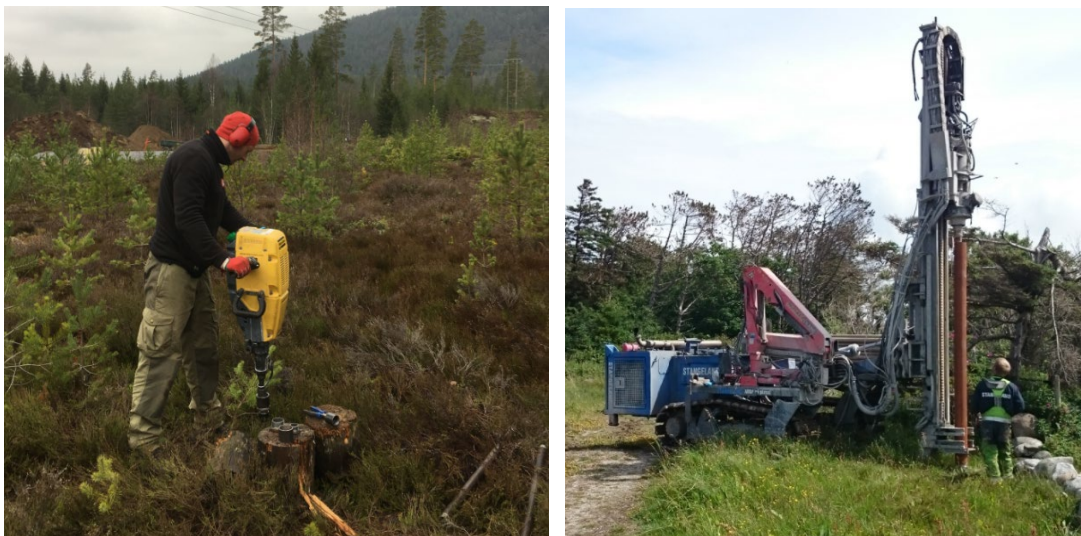
Figur 4.1.4: Boring og nedsetting av grunnvannsrør gjøres enten for hånd med egnet utstyr, eller av innleid brønnborefirma med borerigg. Metode avhenger av jordsmonn og tykkelse på røret. Foto: NVE.
