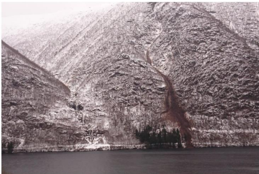
Ved Menes har det gått eit større ras. Som vi ser på bildet har det losna langt oppe i fjellsida, og gått heilt i fjorden. Vegen blir stengt heile helga. Foto: Fredrik Berger Jørgensen
