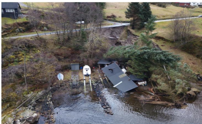
RASSTADEN: Jordrasen er omlag 50 meter breitt, har teke med seg ein del av vegbana og knust eit naust. Foto: Gulen brannvesen
