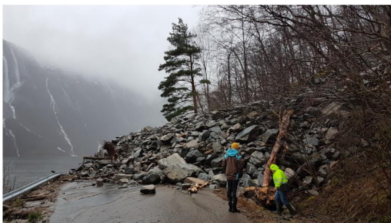
STENGD: Høyanger kommune opplyser at entreprenøren er på staden for å vurdere raset og avgjere når ryddearbeidet kan starte.
