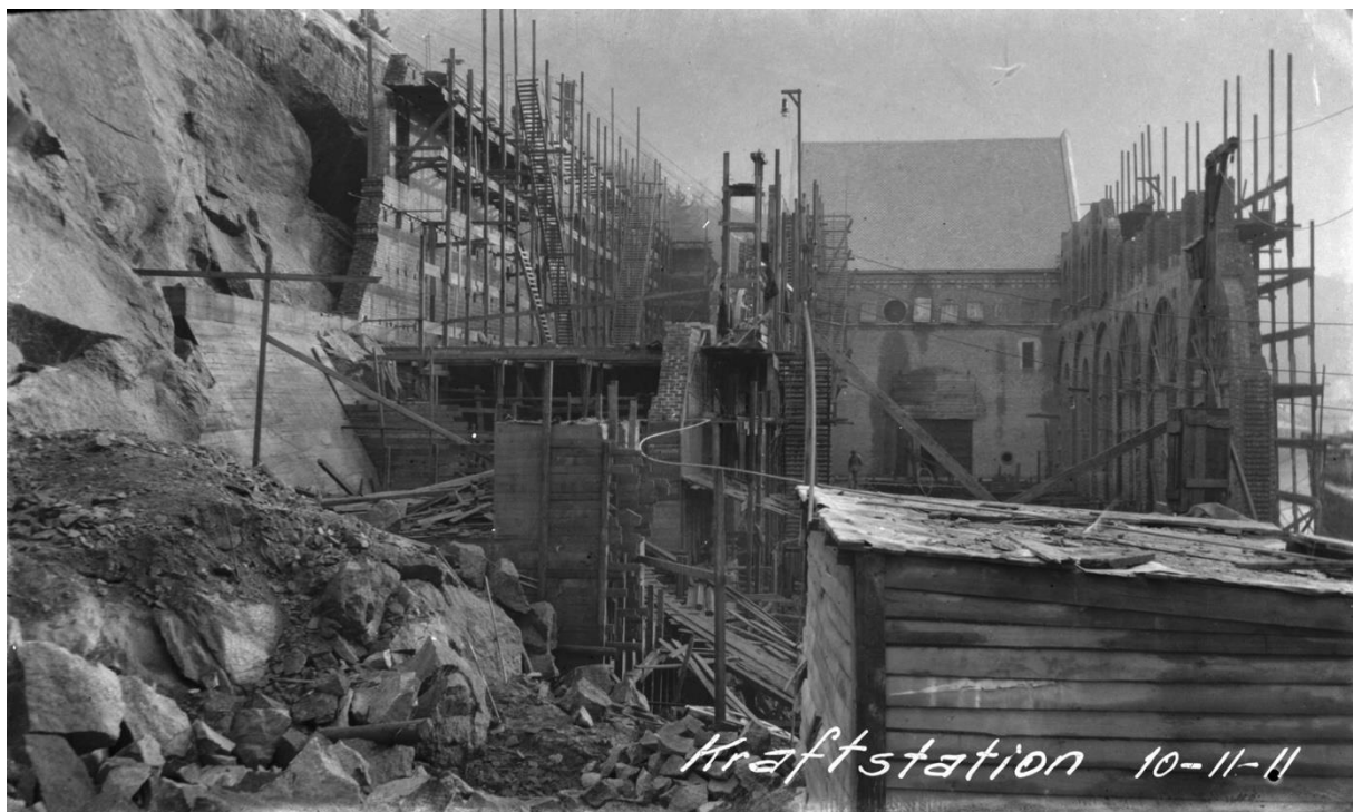
Illustrasjon 9. Kraftstasjonen ble bygget i både stein, betong og teglstein, her fra andre byggetrinn i 1911. Foto: AST/Kraftmuseet, arkivnr. I-TY0260
