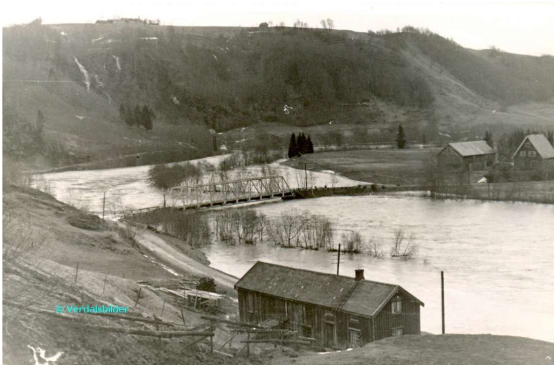
Figur 3-9: Holmen bru under storflommen i oktober 1947. Kilde: Værdalsbruket AS.
