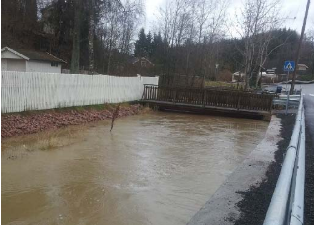
Figur 3-13 Profil 158: Bru til bolighus i Spikkestadveien i Røyken sentrum. Vannstand er 104,5 under flomhendelsen i 2012. (Foto: NVE, 02.11.2012)
