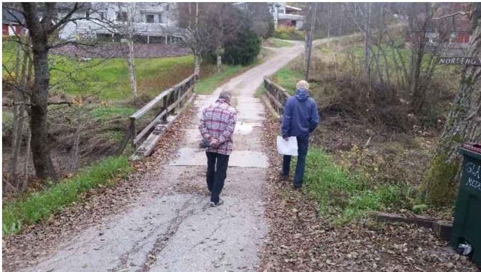
Figur 3-8 Profil 167-168: Bru i Nordengveien med høyde 106,25 på brubanen. (NVE, 04.06.2015)
