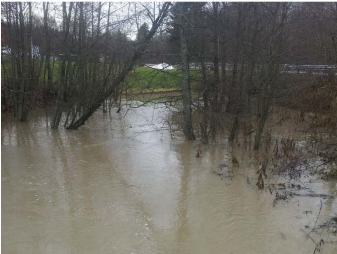
Figur 3-7 Profil 169: Opp mot kulvert under Bråsetveien ved boliger i Bråsetveien 10. Vannstanden er målt til 105,27 under flomhendelsen 02.11.2012. (Foto: NVE, 02.11.2012)
