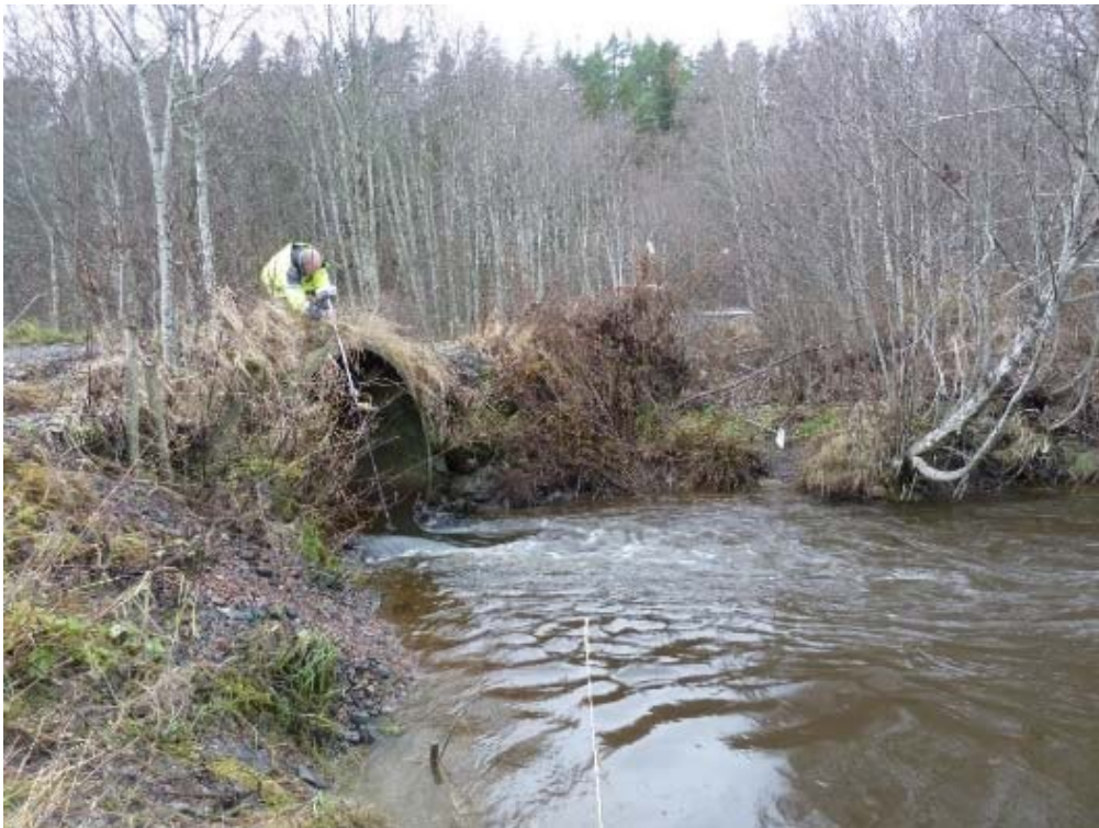
Figur 3-16 Profil 109: Utløp kulvert under Underlandsveien. Kulverten består av ett rør med diameter 2 m. Vannstanden ble den 31.10.2013 målt til 99,76. (Foto: NVE, 31.10.2013)
