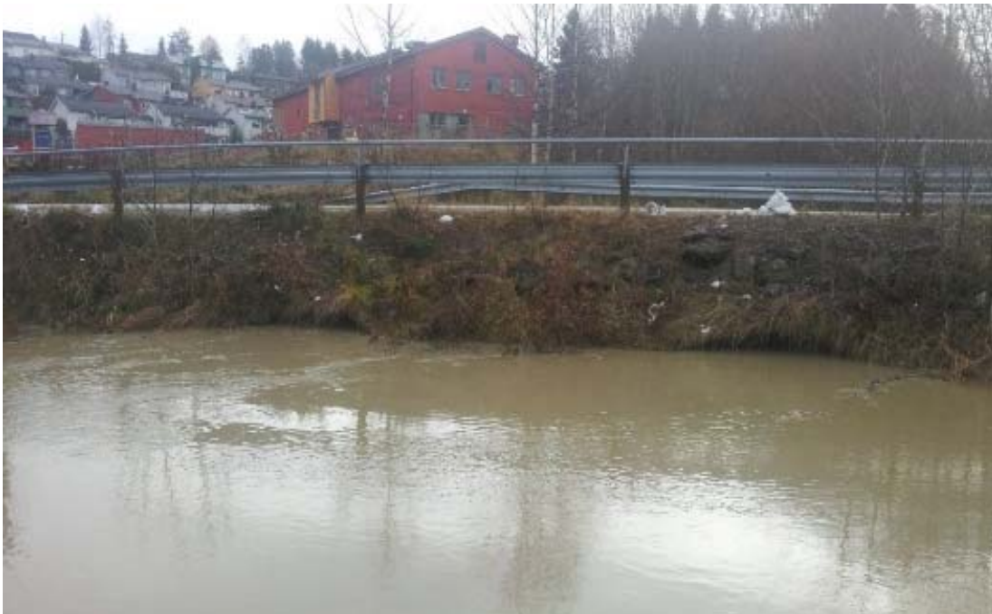
Figur 3-12 Profil 160,3-161: Nedstrøms kulvert ved Røyken senter. Bilde viser flommen den 02.11.2012 og at de 2 elliptiske rørene er nesten fulle med vann. Vannstanden er 104,80. (NVE, 02.11.2012)
