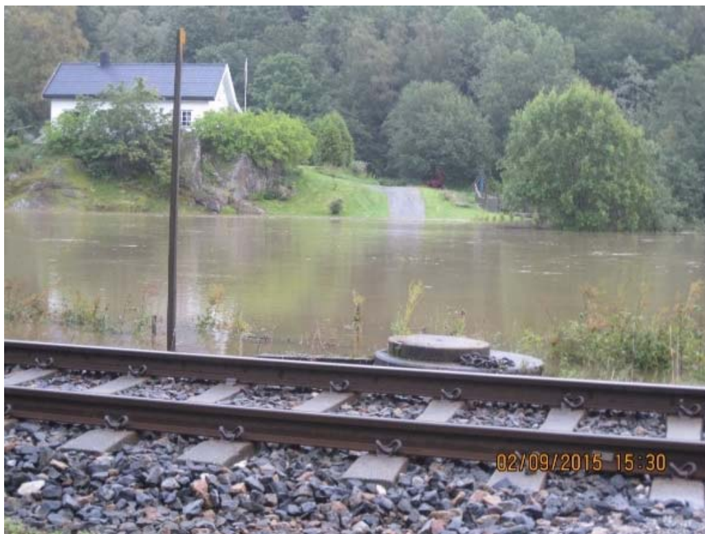
Figur 3-21 Profil 31: Både brua og veien til Haugen er oversvømt og ikke synlig på bildet. Vannstand er 99,25. Høyde på brubane (drukna) er 99,1 og høyden på jernbaneskinne er 100,03. (Foto: Asker kommune, 02.09.2015)
