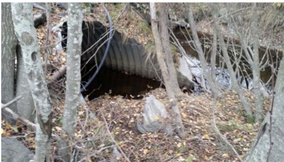
Figur 3-10 Profil 160,3-161: Innløp til kulvert under Bråsetveien i Røyken sentrum. (Foto: NVE, 04.06.2015)
