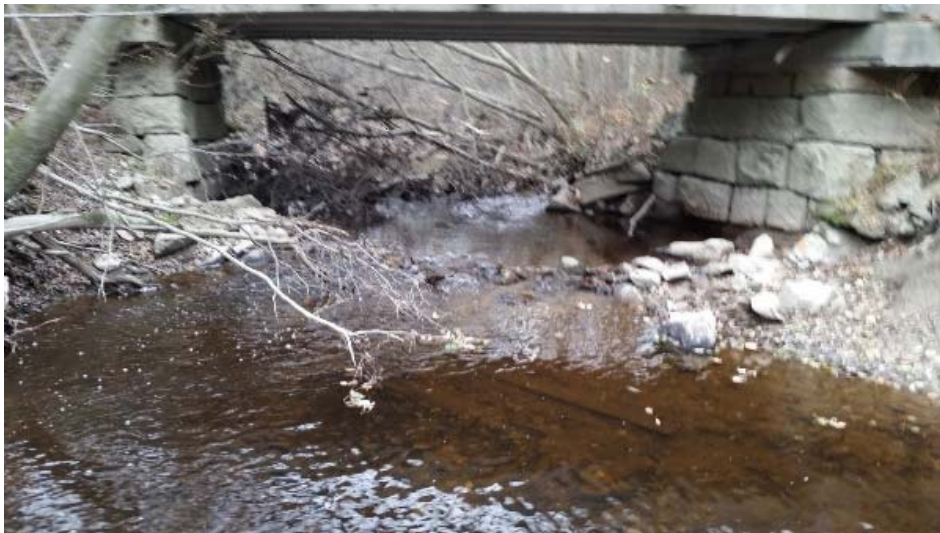
Figur 3-9 Profil 167-168: Oppover mot bru i Nordengveien. (NVE, 04.06.2015)
