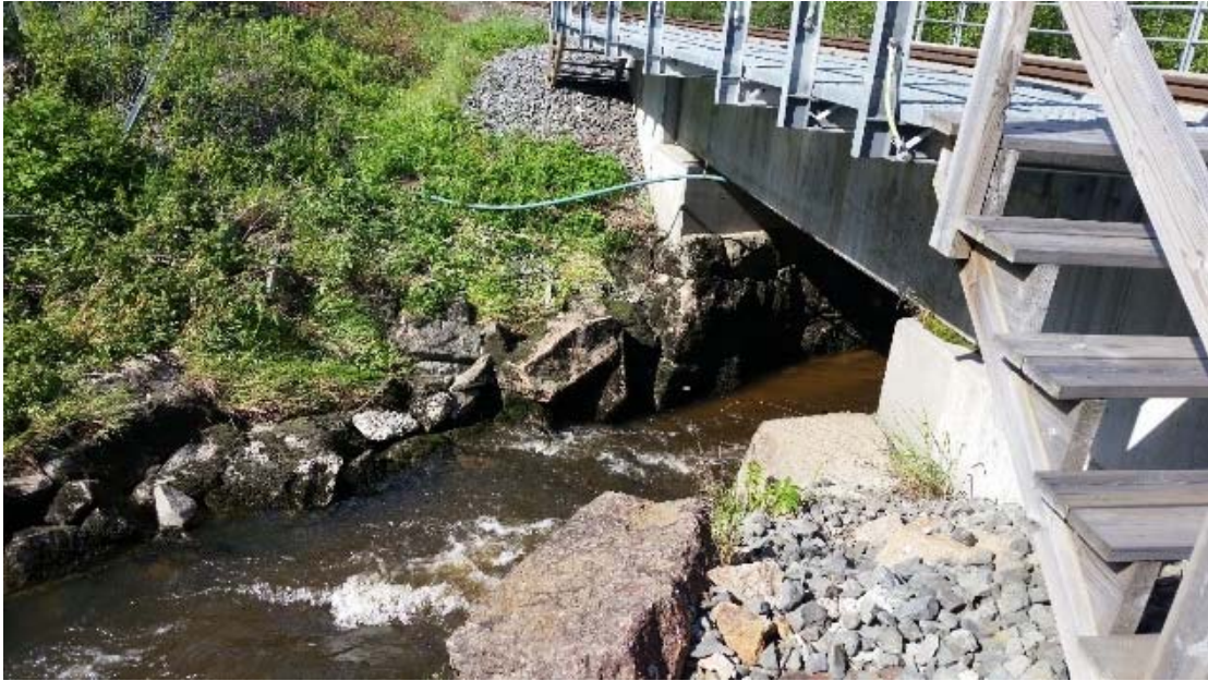
Figur 3-19 Profil 56: Nedstrøms jernbanebru ved Hallenskog. (Foto: NVE, 04.06.2015)
