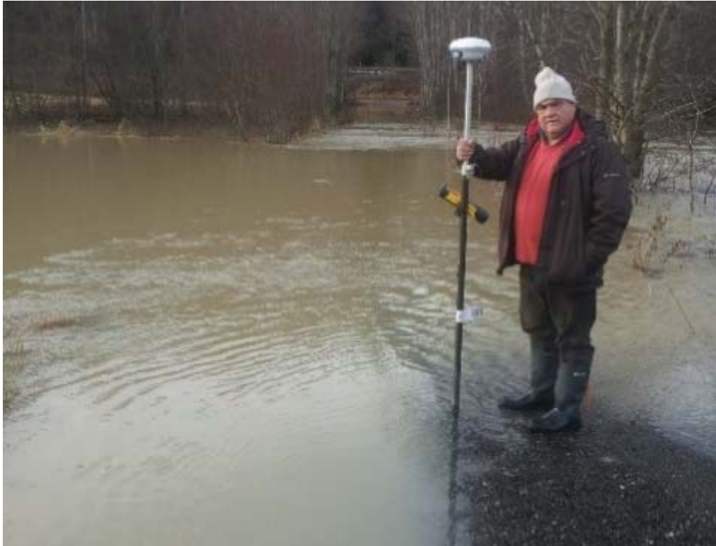
Figur 3-17 Profil 109: Bildet viser at både veien og kulvert ble oversvømt under flomhendelsen i 2012. Vannstanden blir her målt til 101,84. (Foto: NVE, 02.11.2012)
