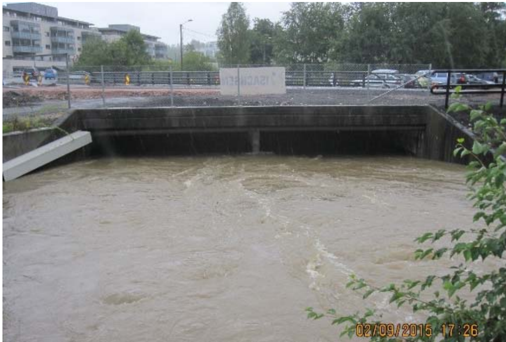
Figur 3-23 Brua nedstrøms Heggedal stasjon under flommen den 2. september 2015. (Foto: Asker kommune, 02.09.2015)
