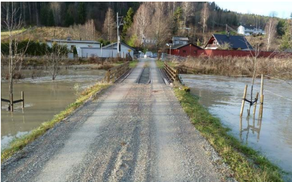
Figur 3-20 Mellom profil 44 og 45: Veibru ved Tangen under flommen den 02.11.2012. Vannstanden er ca. 99,1 og høyden på brubanen er 99,45. (Foto: NVE, 02.11.2012)
