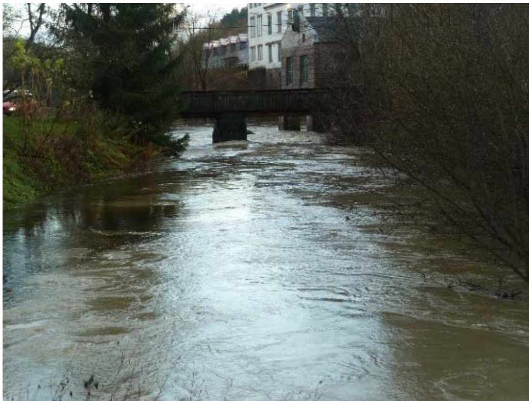
Figur 3-24 Innløpet til Kistefossdammen (profil 0,5): Vannstand i dammen var 96,68 under flommen i 2012. (Foto: NVE, 02.11.2012)
