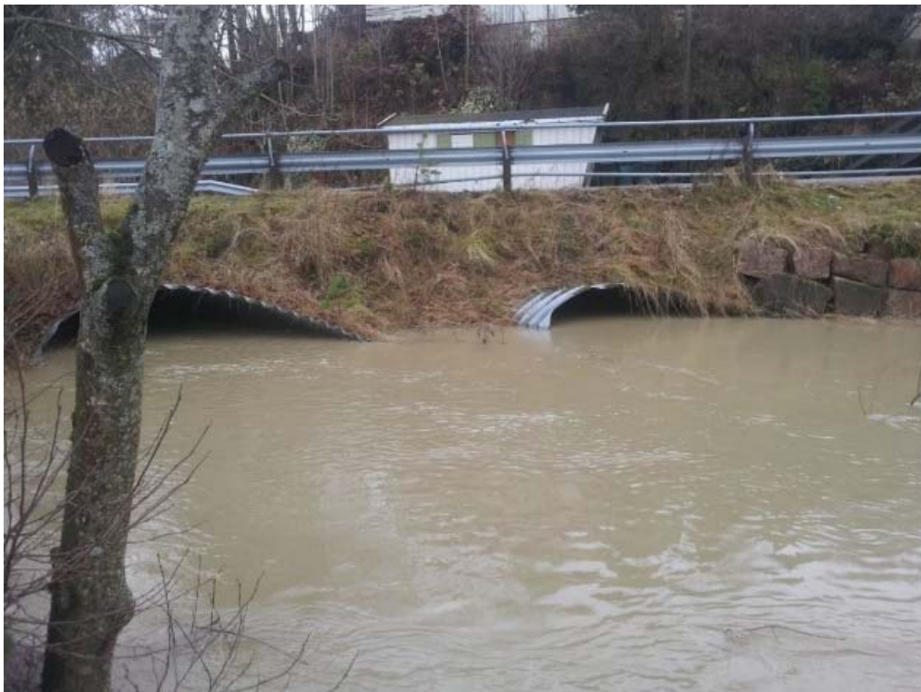
Figur 3-14 Profil 157: Nedstrøms kulvert under Heggveien. Under flomhendelsen 02.11.2012 ble vannstanden målt til 104,37. (Foto: NVE, 02.11.2012)
