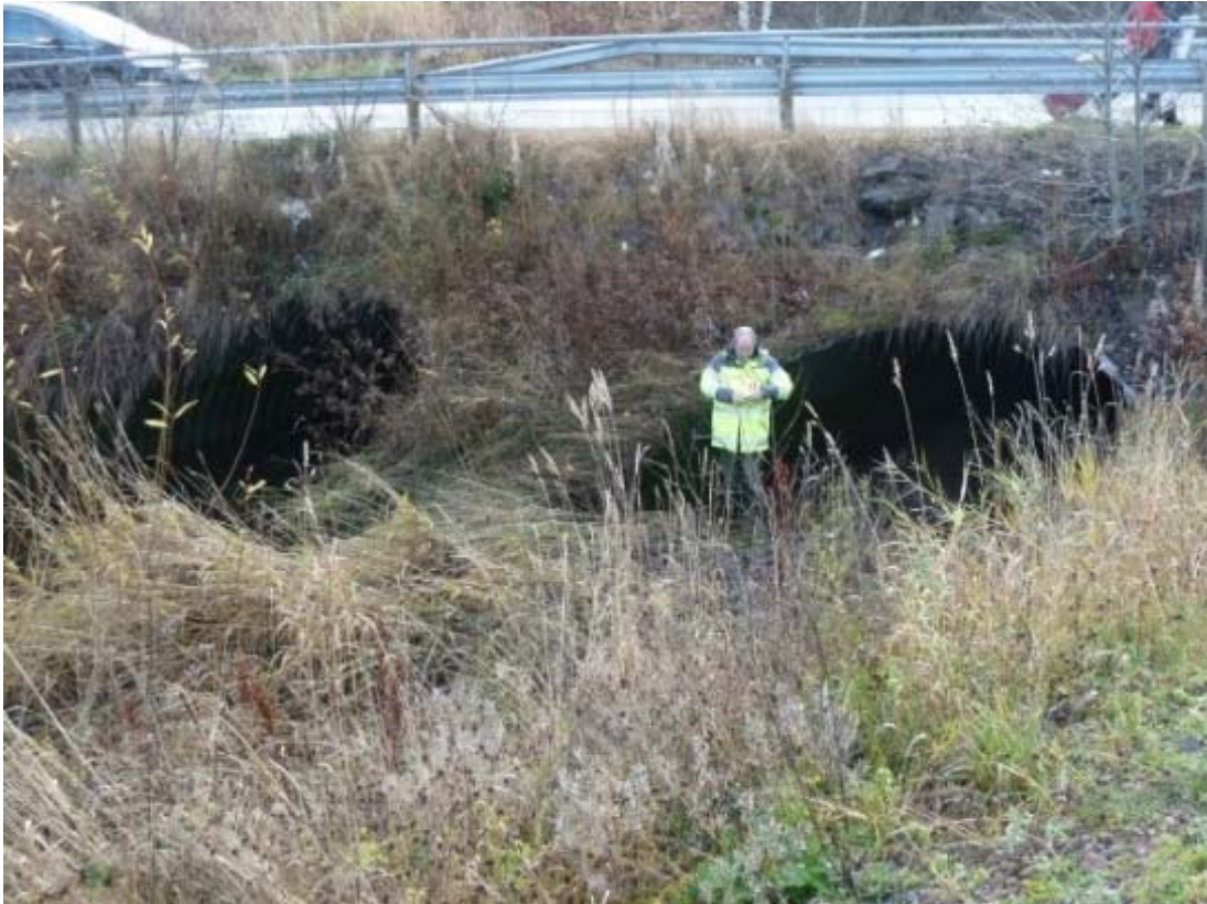
Figur 3-11 Profil 160,3-161: Utløp av kulvert under Bråsetveien i Røyken sentrum. (NVE, 04.06.2015)
