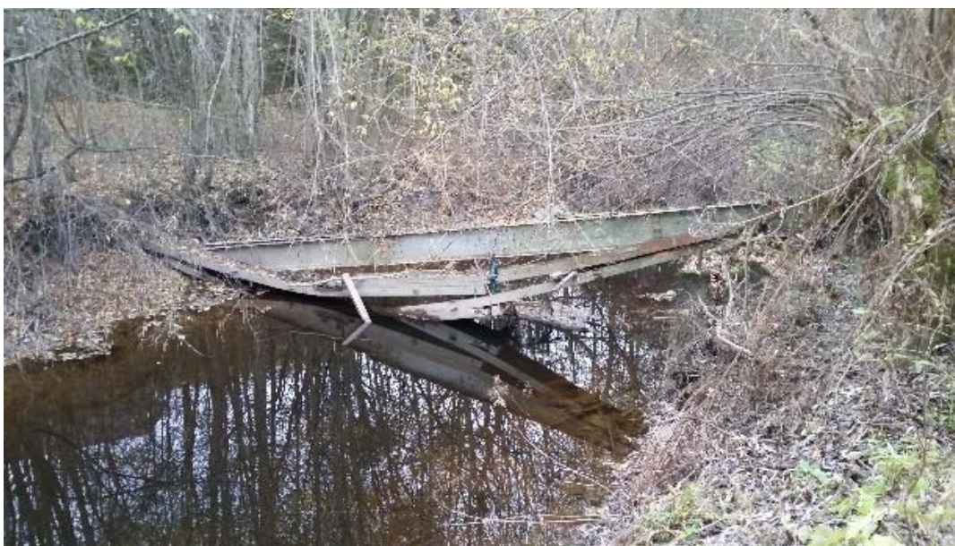
Figur 3-25 Både brubjelke og trær langs elvekanten hindrer strømning i elva. (Foto: NVE, Per Ludvig Bjerke, 04.06.2015)
