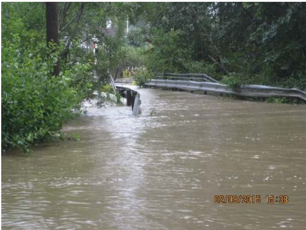
Figur 3-18 Profil 59: Veibru ved Myra under flom i september 2015. Brubane er 100,9 og vannstanden er ca. 25 cm høyere. (Foto: Asker kommune, 02.09.2015)
