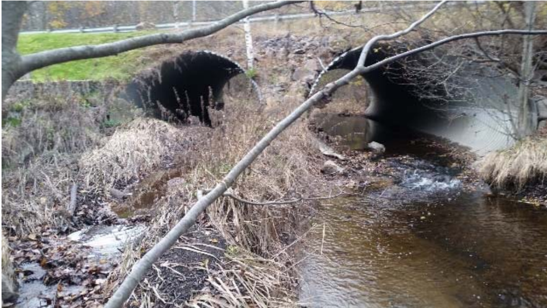
Figur 3-6 Profil 169: Nedstrøms kulvert ved boliger i Bråsetveien 10. (Foto: NVE, 04.06.2015)
