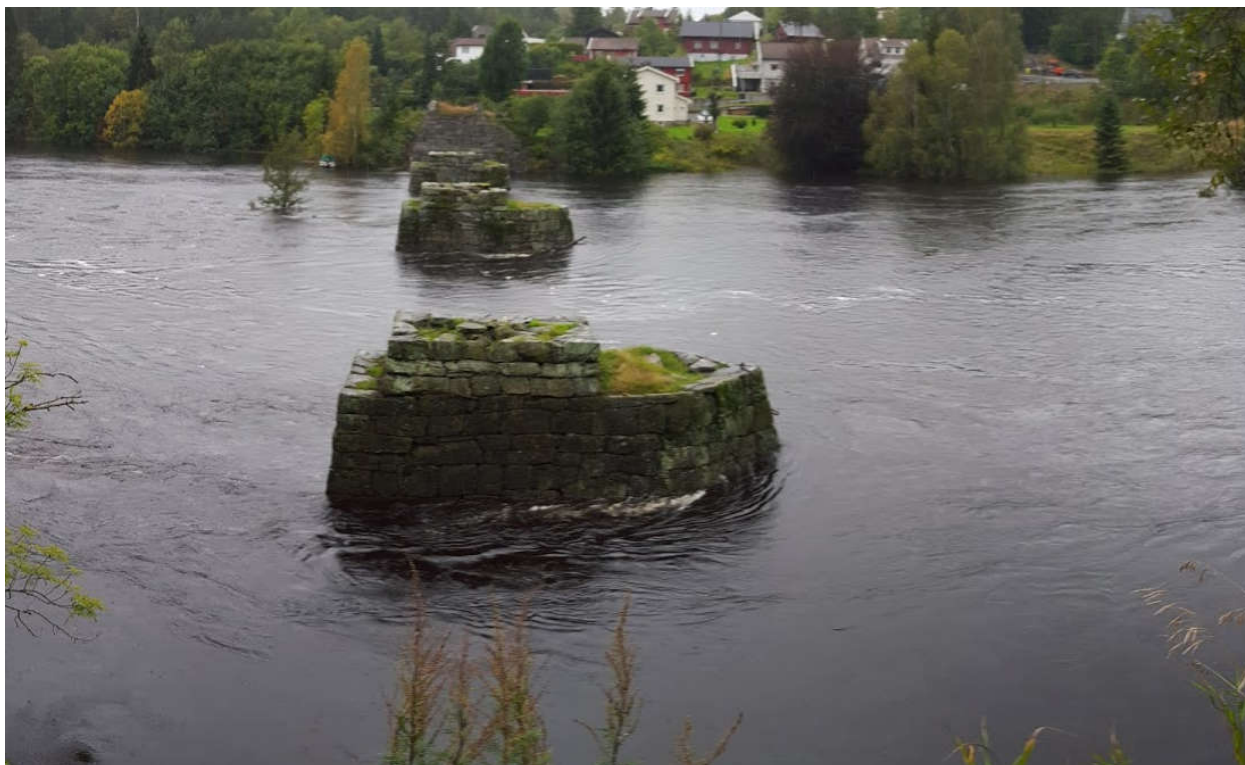
Figur 3-12: Bilde tatt av brufundamentet under flommen i 17.september 2015. Foto: NVE. En ser at brukarene har minimal effekt på vannlinjen selv ved relativt høy vannføring.
