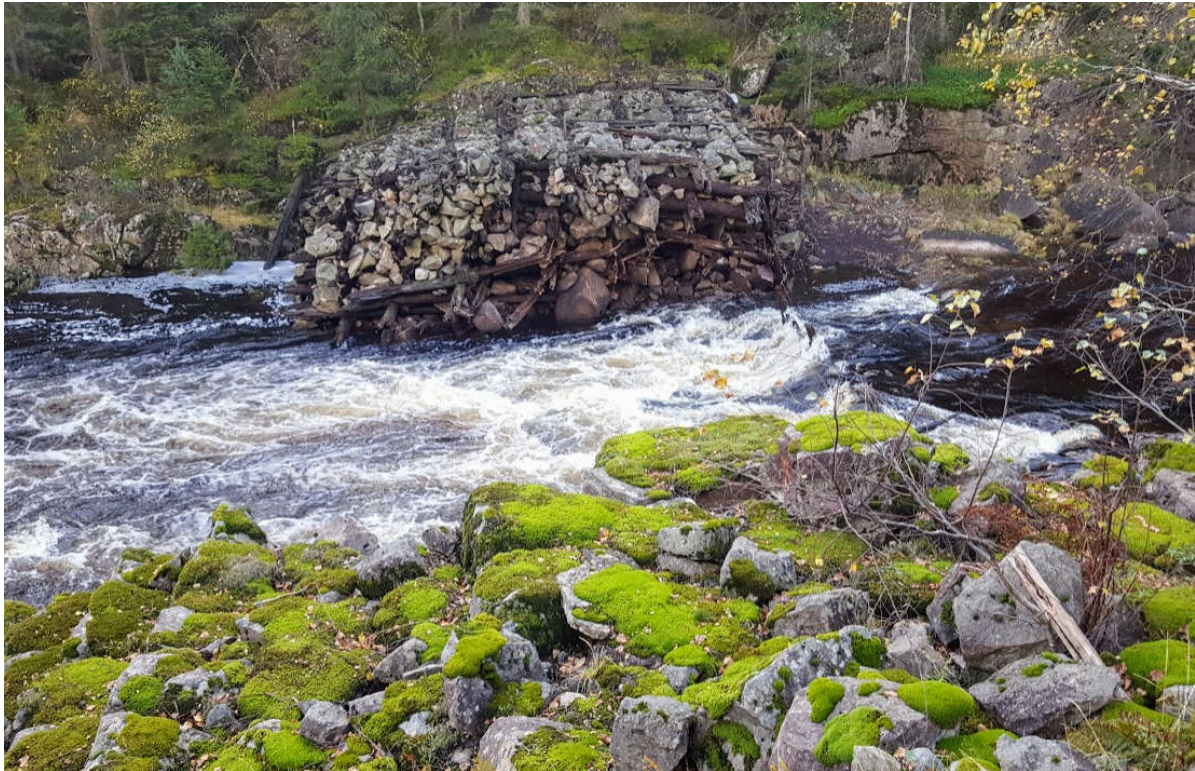
Figur 3-2: Restene av tømmerkistedammen ved Høllen sett tvers over elven. Bildet er tatt fra v.s. sett nedstrøms elven.
