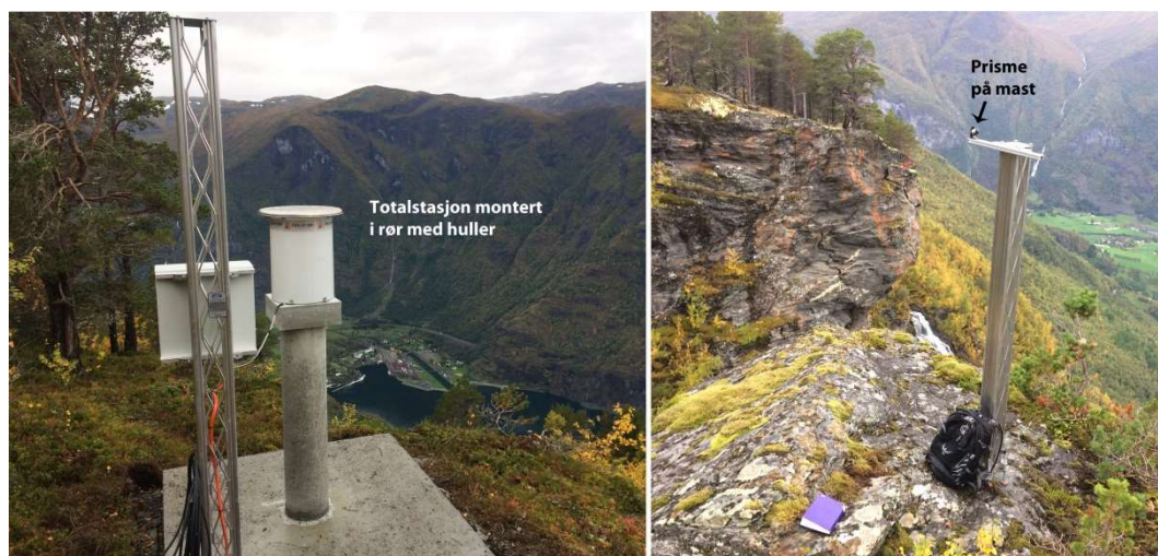
Figur 10 Venstre: Totalstasjon i rør med PC og strømforsyning på masten til venstre. Høyre: En av mastene med prismer.
