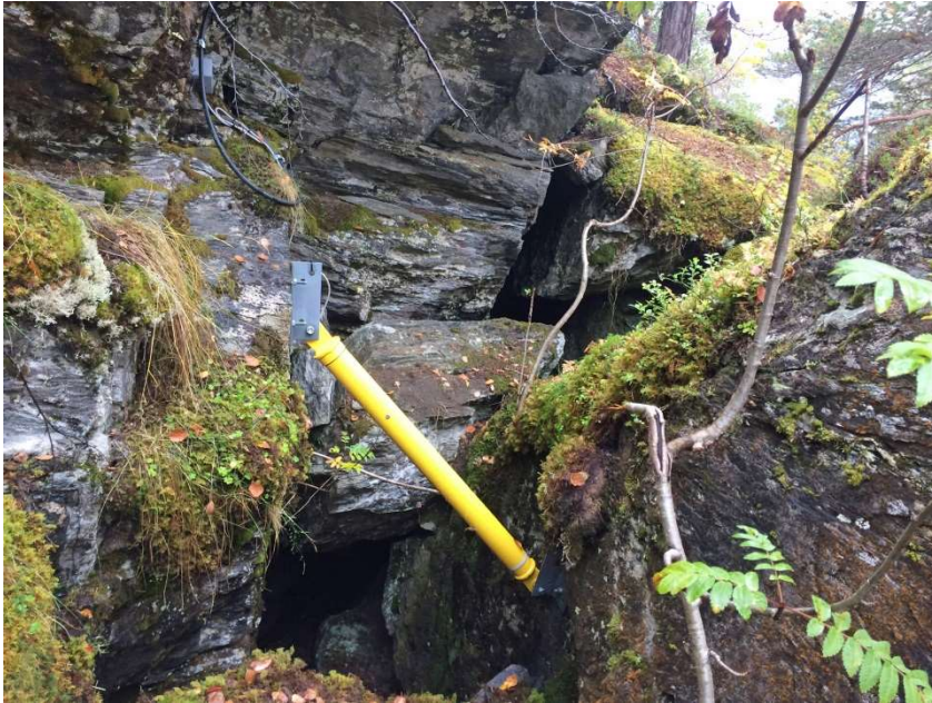
Figur 8 Strekkstag på Joasetbergi. Boltes i fjell på hver side av en fjellsprekk og måler bevegelse i sprekk.
