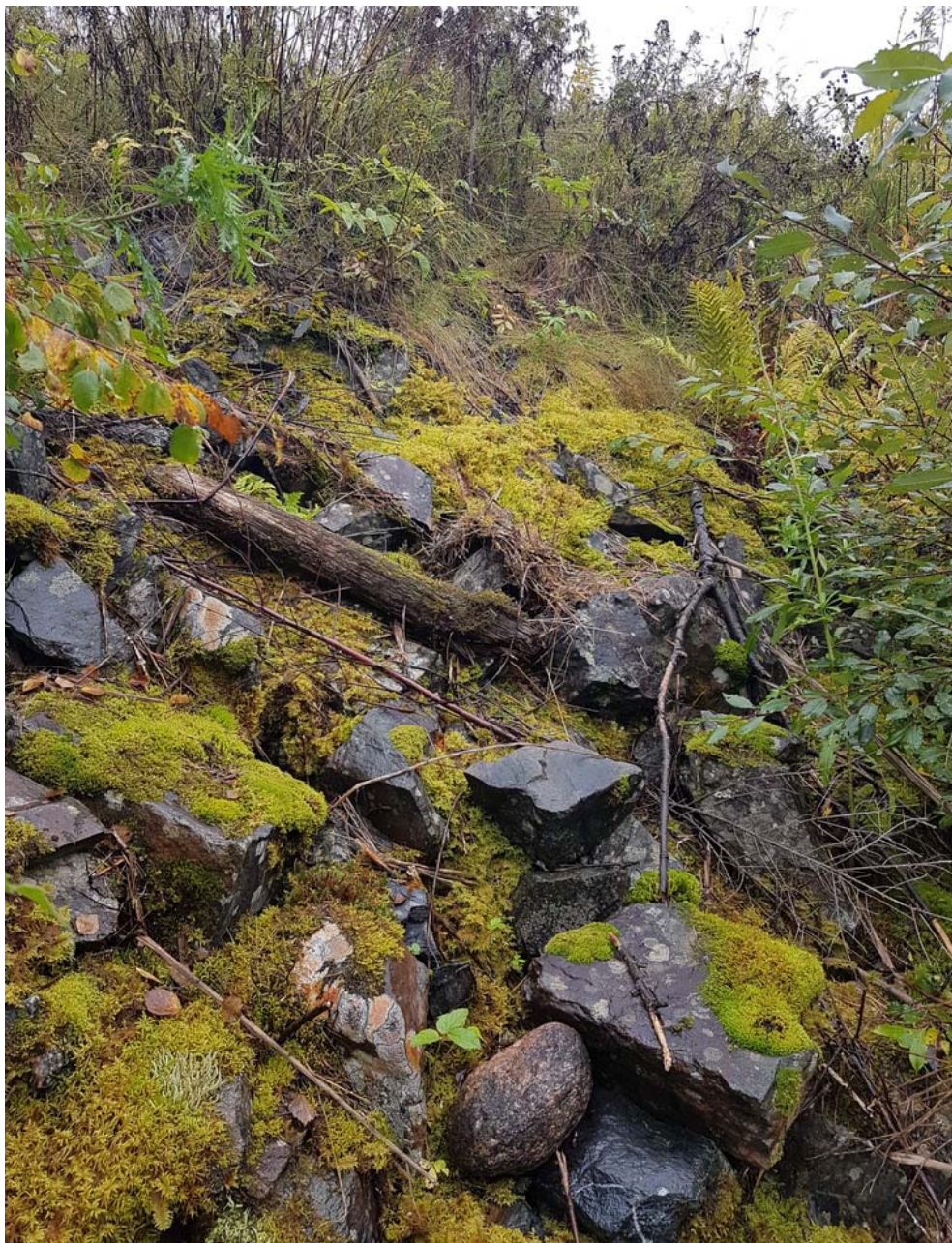
Figur 8 – Erosjonssikring ved pumpestasjon (Bilde Multiconsult)
