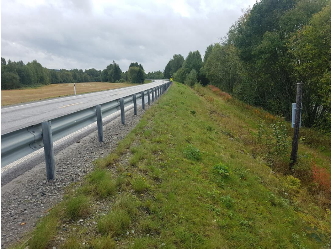
Figur 6- Typisk utforming av flomverket Rymoen- Roverud (Bilde: Multiconsult)
