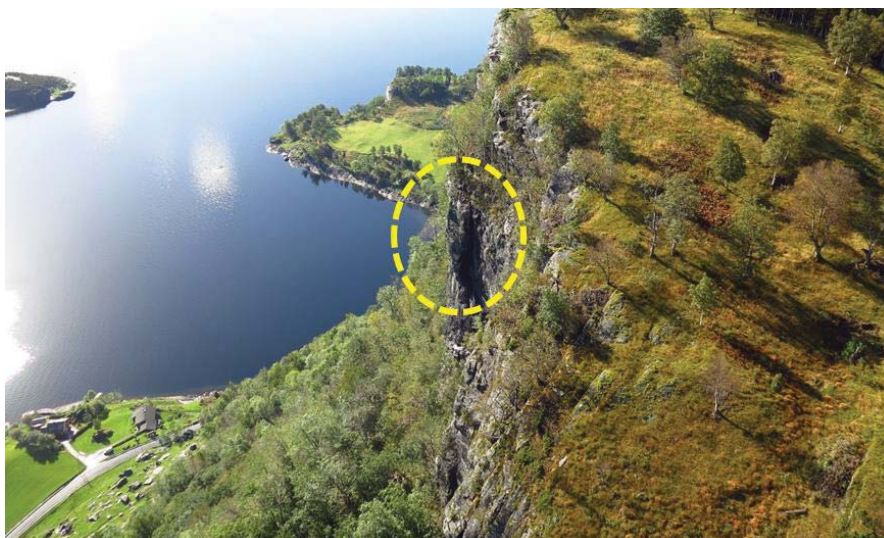
Bilde 16. Et stort ustabilt bergparti ved Flotve. Bildet er tatt mot sør/sørvest.
