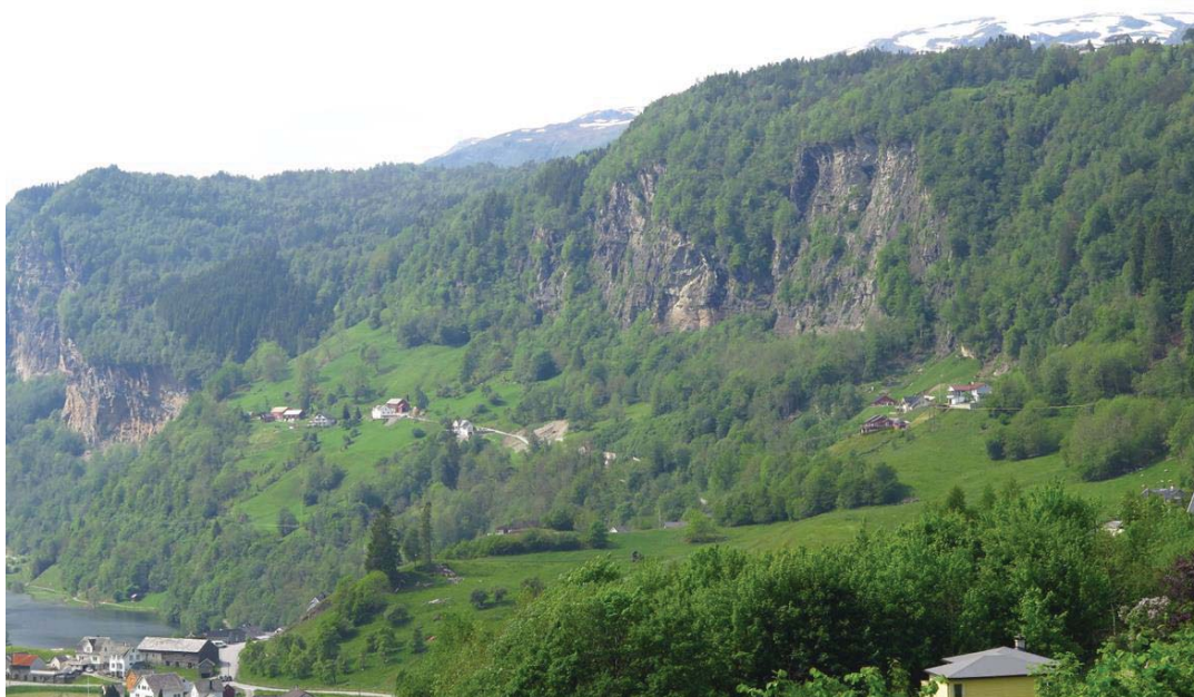
Bilde 12. Steil bergskråning ved Skutlaberg er løснеområde for steinsprang og blokkskred. Bildet er tatt mot vest/nordvest.
