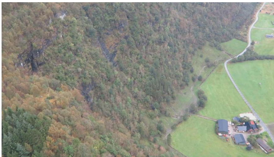
Bilde 41. Krokane har steile bergskråninger med nær loddrette fall, men bebyggelsen ligger i god avstand fra skråningen (100 m). Bilderetning mot sør.
