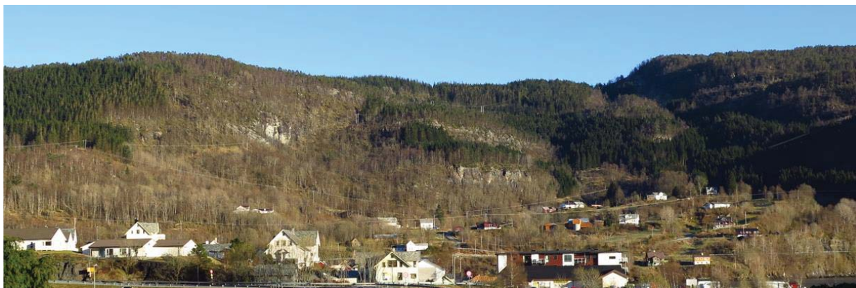
Bilde 32. Oversiktsbilde av del av skråningene ved Eikeland (Nedre Eikeland til høyre i bildet), sett mot sør.
