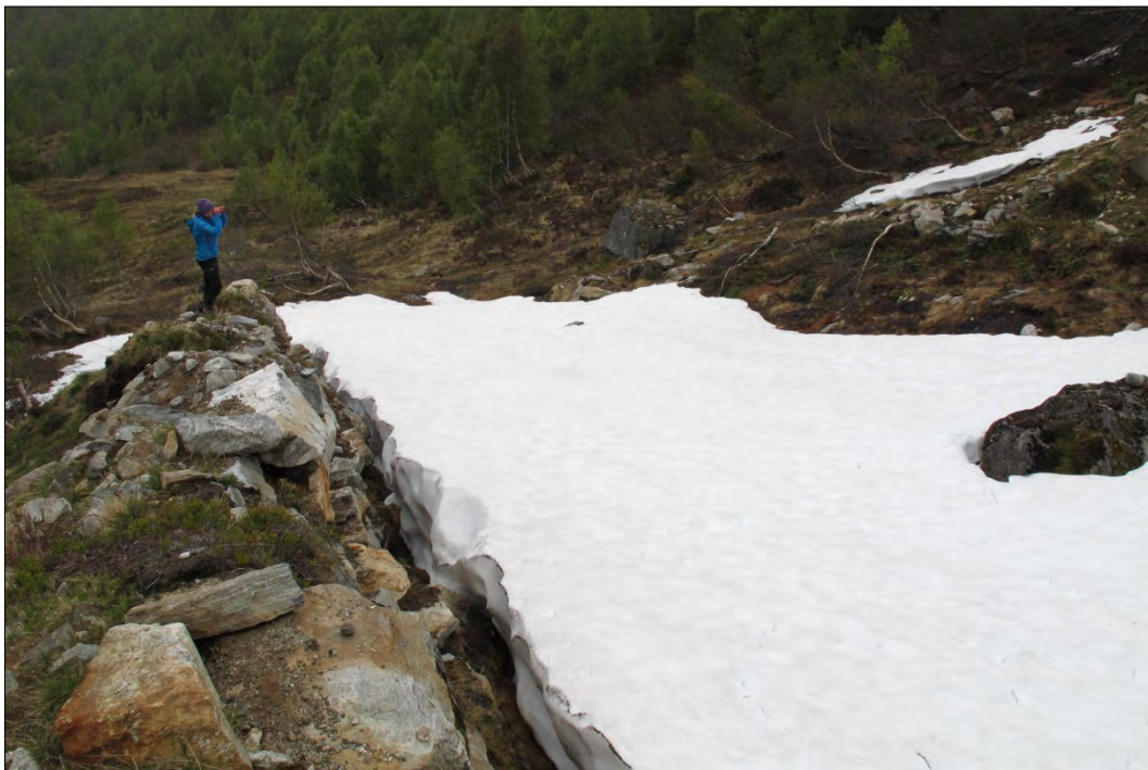
Fig. 4.3.1.3. Fangvoll oppført rett under løsneområdet til Klovfonna, mellom 600 og 650 moh.
