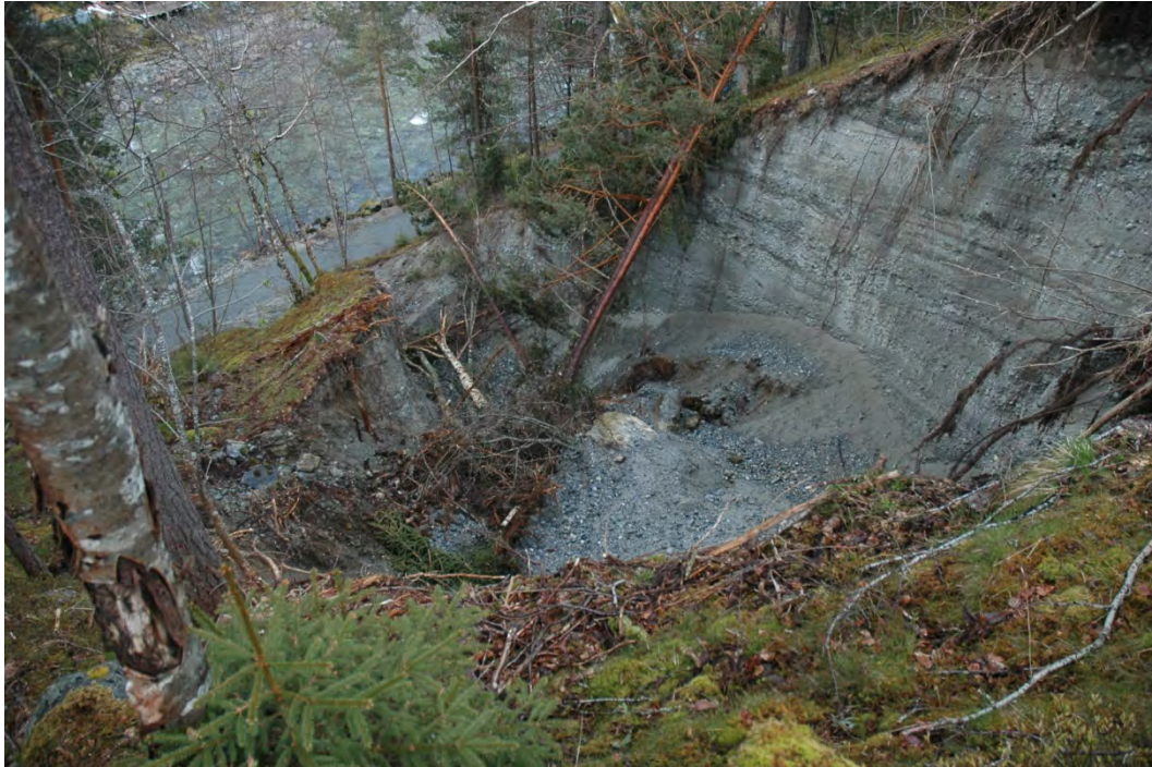
Fig. 4.3.3.1. Skred i kanten av elveterrassen ved Murigjerde.
