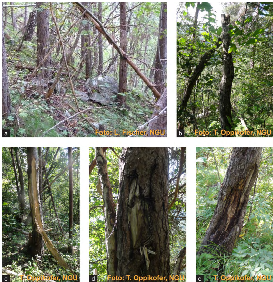
Figur 6.3.2.5. Skog ved foten av Syltefjellet. Det er observert at mange trær viser støt fra steinsprang eller er døde, samt generell skogstilstand er ganske dårlig og beskyttelsesfunksjonen er begrenset.
