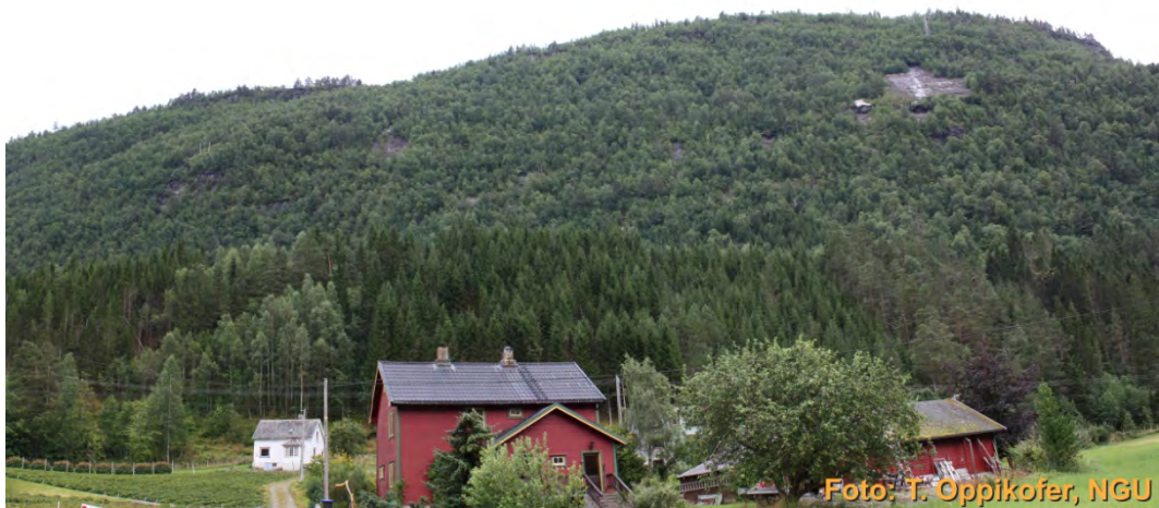
Fig. 7.1.1. Oversiktsbilde av den vestlige delen av området 4: Jamtekvisla – Bjorstad ovenfor Øygarden. Skrenter er synlig midt i og øverst i skråningen.
