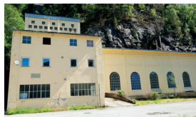
Hovedbilde og over: Kraftverkene Sunda I, II og III er del av en stor nedleggelse der det har vært et behov for standardisering av dokumentasjon er stort. Foto: Uno Ylmarz/ NVE.
