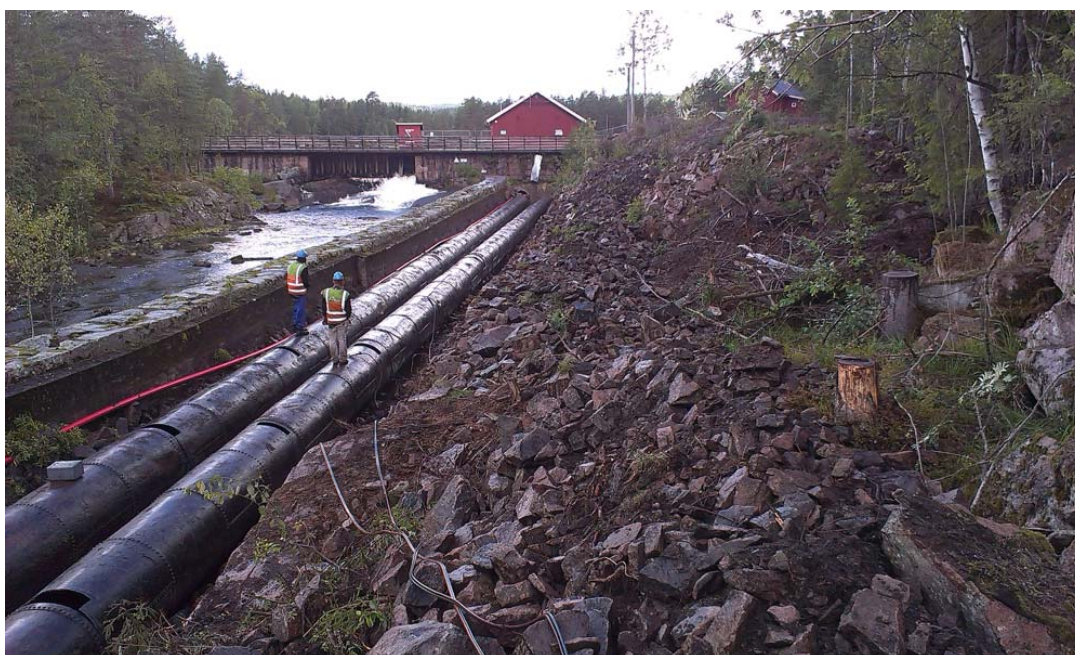
Gamle rør er gravd opp, mot dammen. Foto: E-CO Energi/Oslo Lysverker 2014.
