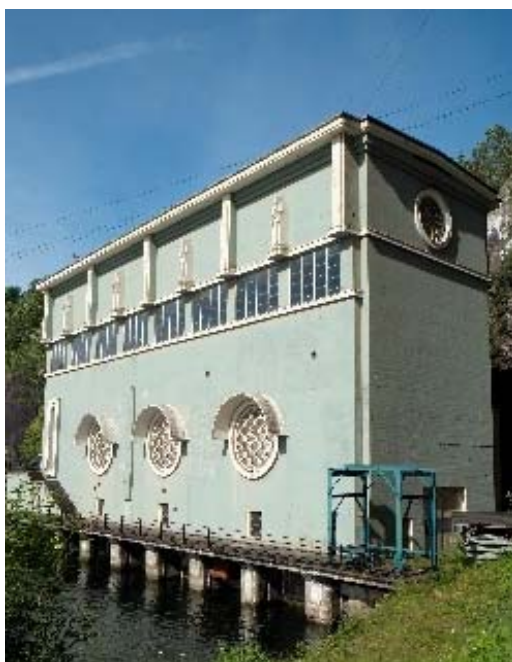
Kraftverkene Sauda fra ø.v: Kraftstasjonen Sauda III, Maskinsalen i Sauda I, Kraftstasjonen Sauda I.
