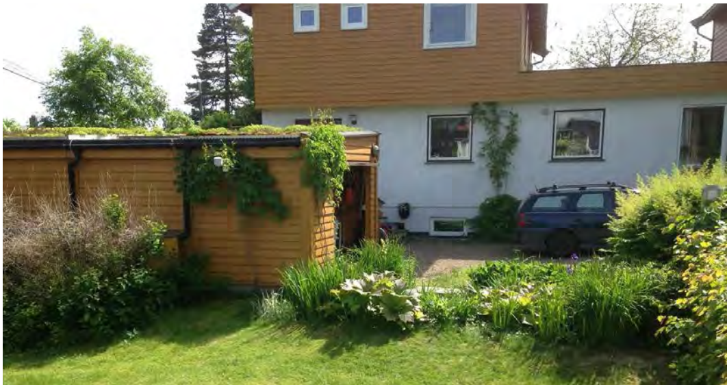
Figur 35. L34b består av to forsøksfelt: Grønt tak på garasjen og et regnbed mellom garasjen og nedbørmåleren i hekken til høyre i bildet. Merk lufttemperaturmåler på veggstativ på garasjens nordside. Huskroppen skygger det grønne taket midt på dagen.
