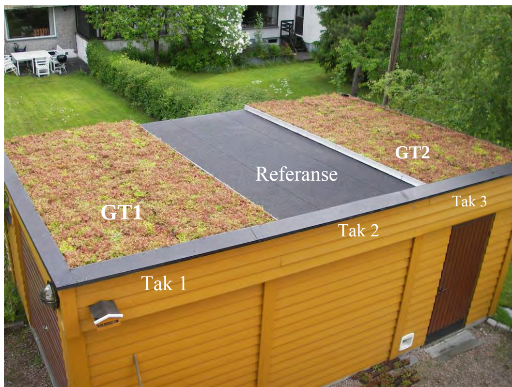
Fig. 5. Nyanlagt, grønt sedumtak på garasjetak, 2009. Taknummerering er gitt.
