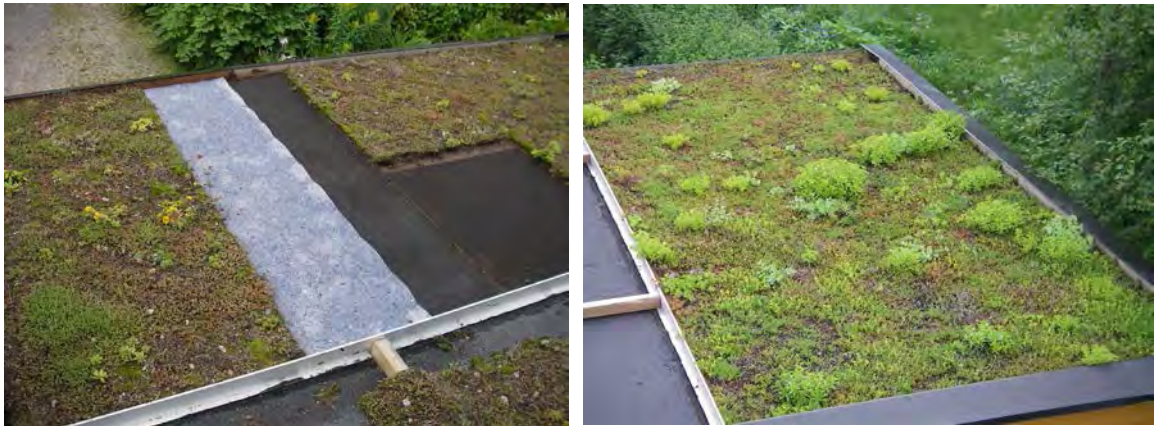
Figur 7. Ombygging av GT 1a til GT 1b pga. dårlig vekst sammenlignet med GT 3 (høyre bilde), 8. aug. 2011. En filtmatte legges oppå dreismatta for å øke vannlagringen (fig. 6). Forskjellen mellom GT 1b og GT2 er etter dette kun dreismatta i GT 1b.
