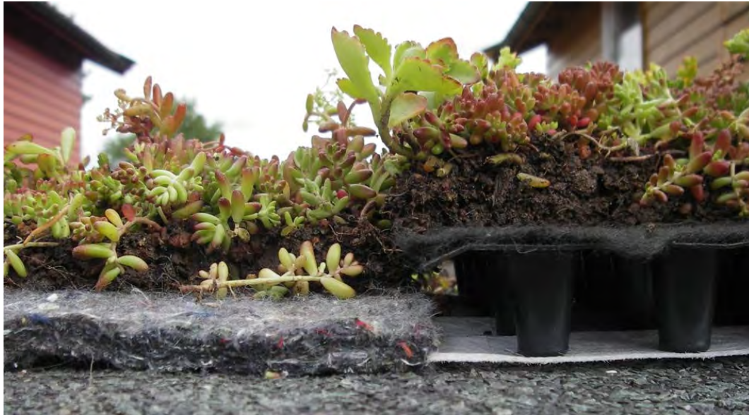
Fig. 6. Oppbygging av Tak 3 (GT 2) (venstre) og Tak 1 (GT 1a) (høyre). Tak 1 ble seinere endret noe sommeren 2011 (filtmatte ble lagt mellom dremsplate og sedummatte; GT 1b).
