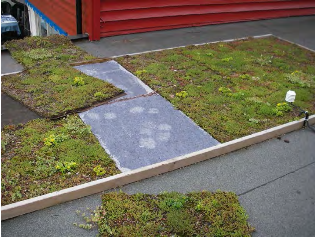
Fig. 43. VT-filt legges over drengspata på rutene 141 og 151 (som GT 1b). Filten klippes der rutene møtes for å redusere vannsigg fra våt til tørr sone, og vannes før sedummattene legges tilbake.
