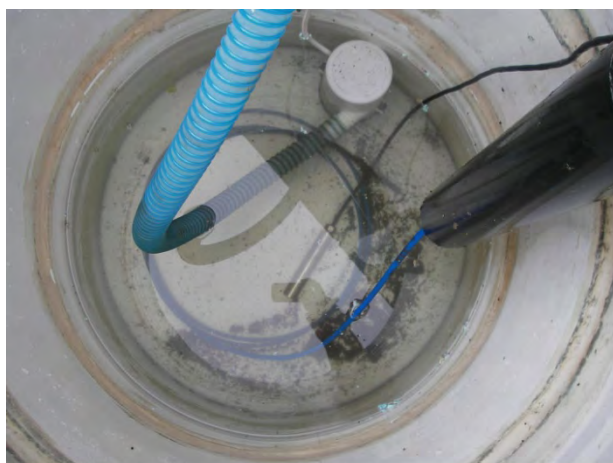
Figur 8. Vann samles i isolerte dunker med varmekabel, trykksensor og pumpe for automatisk lensing.
