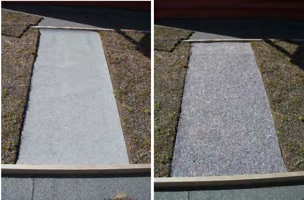
Fig. 45. Takpapp legges oppå platene før VT-filt dekker det hele. Filtet klippes i overgangen rute 143 og 153, før sedummattene legges tilbake (som GT 2).
