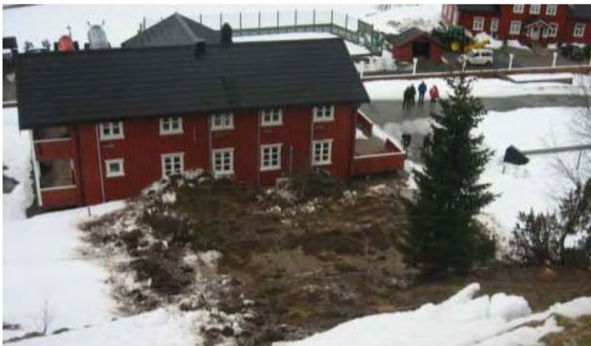
Fig. 2. Grunne jordskred nært bebyggelse. Gilandtunet ungdomshjem i Hølonda, Melhus. 13.03.12. Poretrykksutløst moreneskred. Foto: Andrea Taurisano.
