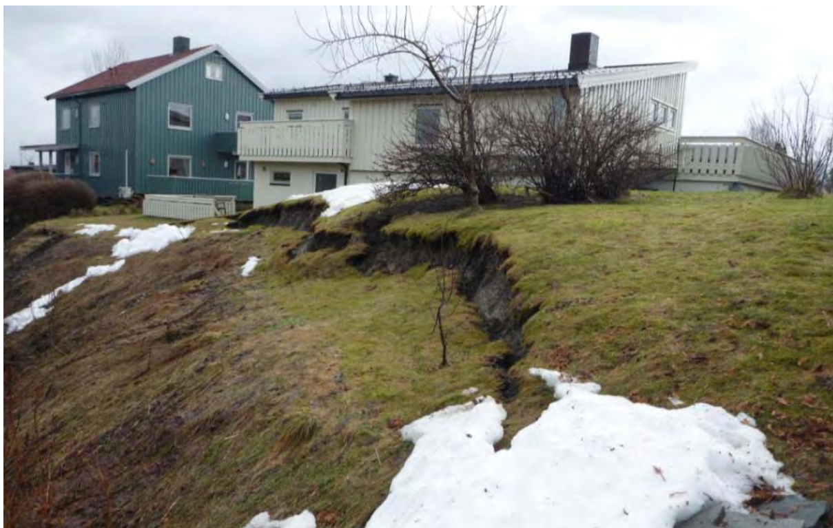
Fig. 17. Hareveien, Byåsen, Trondheim. Poretrykkrelatert utglidning i leir- og tilførte masser ("hageutglidning"). Foto: Terje H. Bargel.
