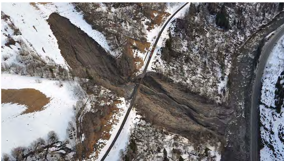
Fig. 15. Jordskredet i Sokndalen skjedde i to omganger med temmelig nøyaktig ett døgns mellomrom: 1) ca. kl 04:00 13. mars 2012 løsnet jordmasser over jernbanen (til venstre på foto), massene tettet igjen drenerørret gjennom jernbanefyllinga. Massene tok seg også over sporet, ned skråningen, over elva og stengte E6 på andre siden. Vann ble demmet opp bak fyllinga. 2) ca. kl 04:00 14. mars 2012 brøt vannet seg gjennom fyllinga og fjernet denne over en strekning på ca. 30 m, og ny runde med skred mot vei. Foto: Ole Jørgen Kjeldal 18.03.2012.
