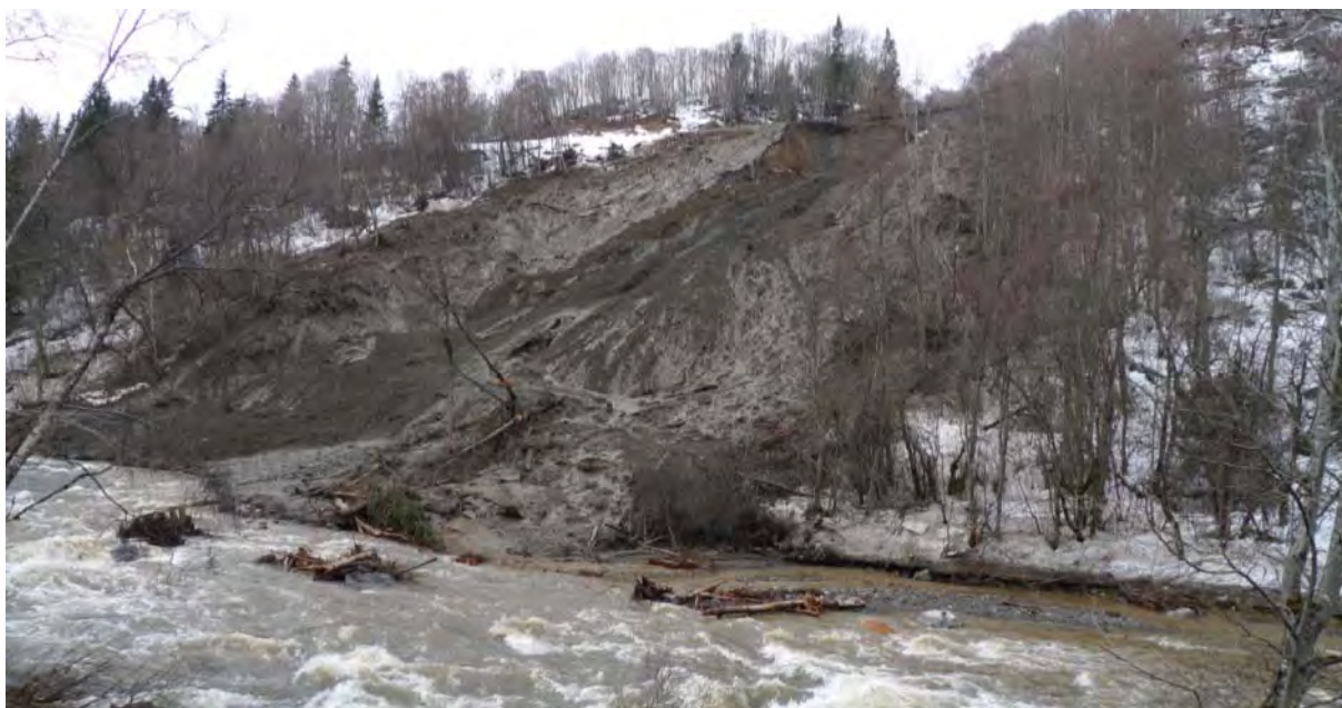
Fig. 14. Dovrebanen i Sokndalen var fyllingen rast ut ca. 30 m etter jordskred og oppdemming/dambrudd. Fortsatt ustabile masser oppe til venstre. Banen ble ikke åpnet igjen før 09.05.2012! Foto: Terje H. Bargel.
