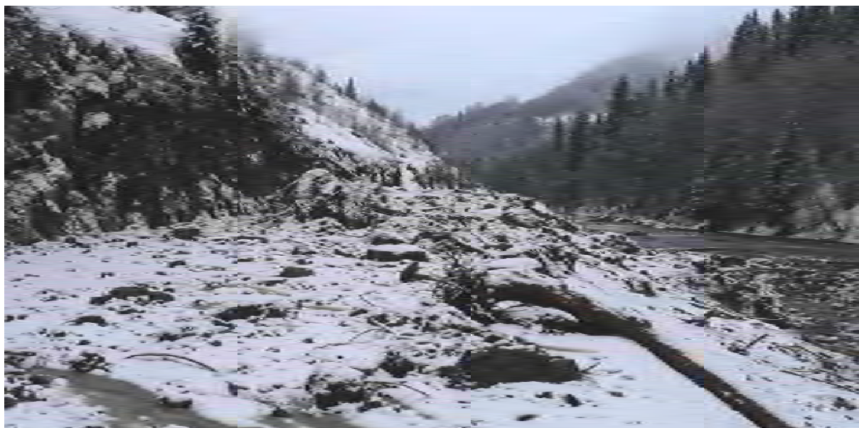
Fig. 13. E6 i Sokndalen ble stengt 13.-14.03.2012 etter at et jordskred ødela Dovrebanen, som går opp i lia til høyre, fortsatte over elva og opp på motsatt side. Veien ble raskt ryddet og åpnet igjen. Foto: Terje H. Bargel.
