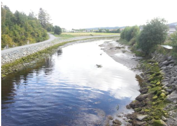
Figur 6-1: Elven er steinsatt på begge sider ved utløpsområdet ved Holme bru og oppover langs den nye turveien langs elva. Foto: Kjartan Orvedal, NVE.
