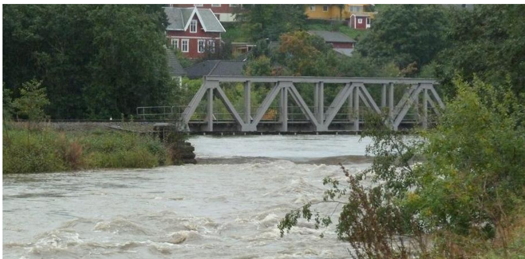
Figur 3-5: Jernbanebrua under flommen 14.september 2011. Vannstandsspranget under bruen viser at vannstanden nedstrøms bruen ikke påvirket vannstandene oppstrøms bruen under flommen. Foto: Per Ludvig Bjerke, NVE.
