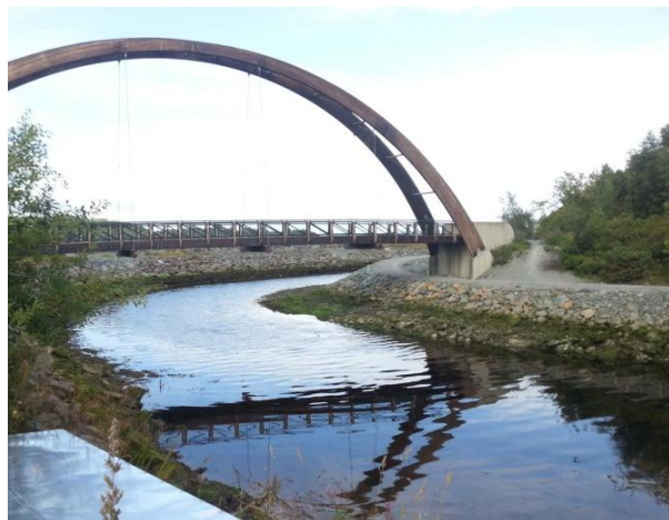
Figur 6-1: Elven er steinsatt på begge sider ved utløpsområdet ved Holme bru og oppover langs den nye turveien langs elva. Foto: Kjartan Orvedal, NVE.
