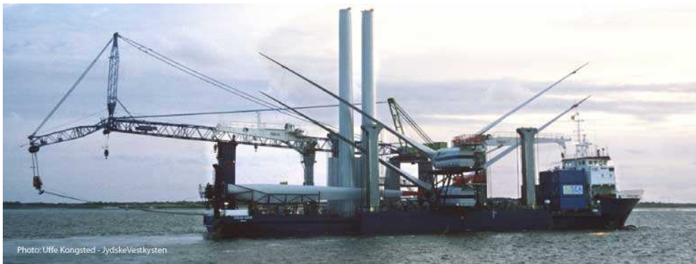
Figur 3-1 Ombygd båt for transport og installasjon av offshore vindkraft (Kilde: www.a2sea.com )
