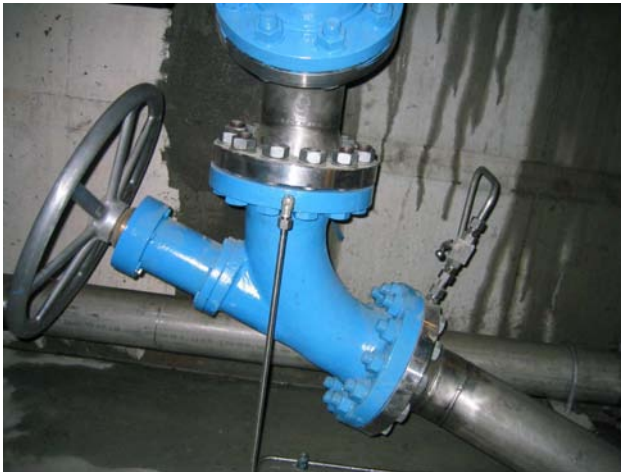
Figur 6 - Nåleventil for små vannføringer og høye trykk (BKK) Figur 7 - Konusventil (Br. Dahl)
