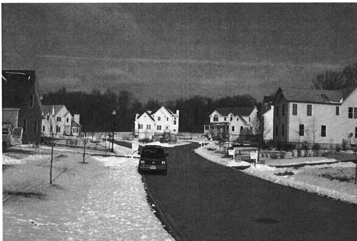
Figur 5. Nybygd boligfelt med lokal overvannsdiskonering (LOD) i Connecticut, USA. Aktuelle LOD-tiltak som er brukt: Vanngjennomtrengelig (permeabelt) vegdekke, grunne grasdekte grøfter som leder overflatevannet vekk og lar det infiltrere, og bed med vannkrevende arter (regnbed). Sentralområdet midt i bildet (bak bilen) kan oversvømmes midlertidig (foto: M. Hood).
