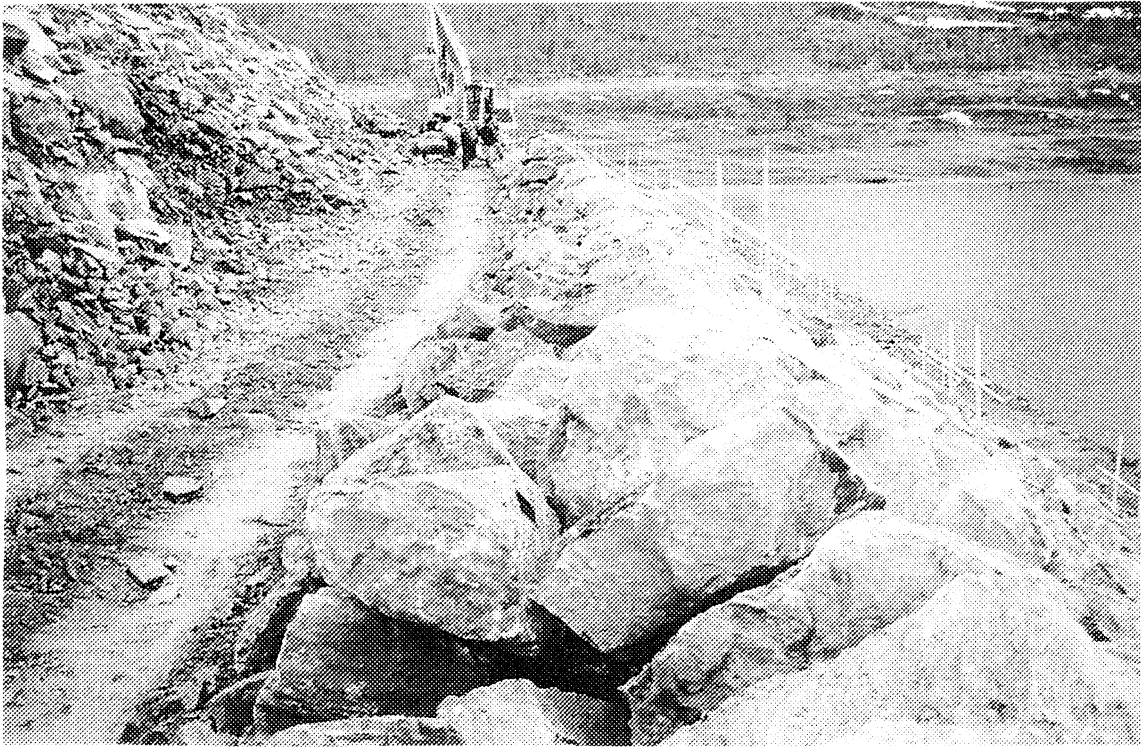
Dam Follsjø, rehabilitering og forsterkning av oppstrøms skraning
