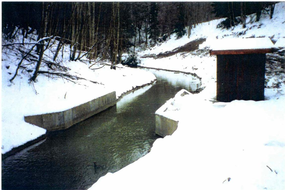
Fig 2. Målestasjonen for vannføring (Crump - overløp) og sedimenttransport i Sogna, stnr. 2.10.0.1000.1.
