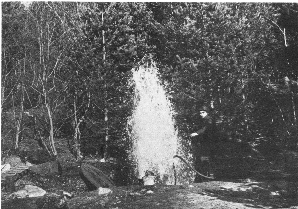
Figur 12. Blåsing av rørbrønnen (6") i Nedre Eidfjord
