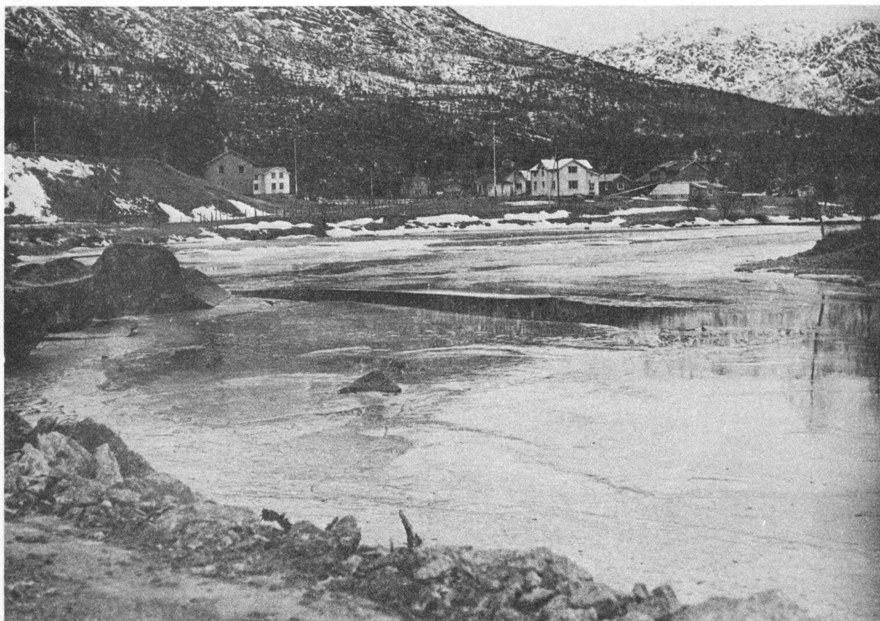
Sett fra brua nedover
