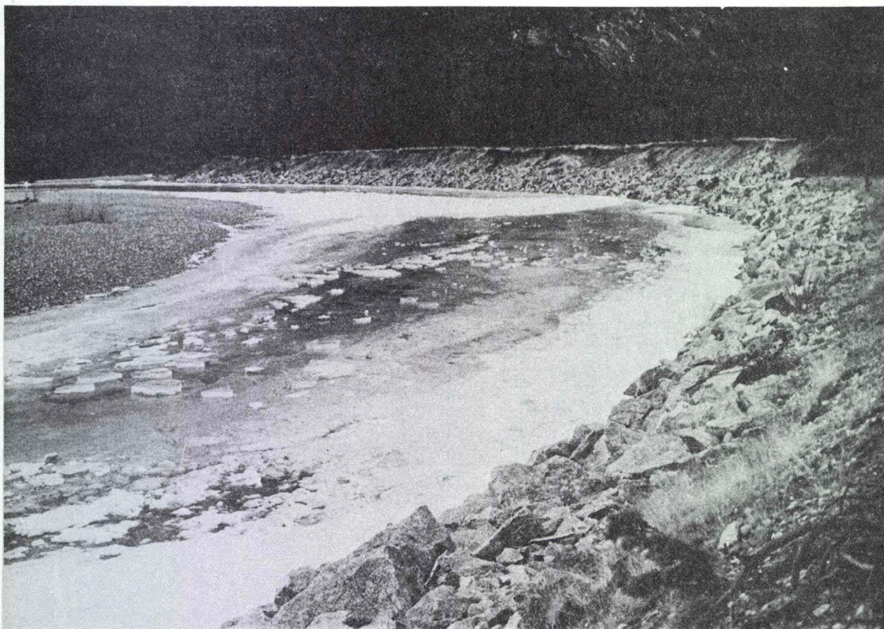
Forbygging langs høyre elvebred
