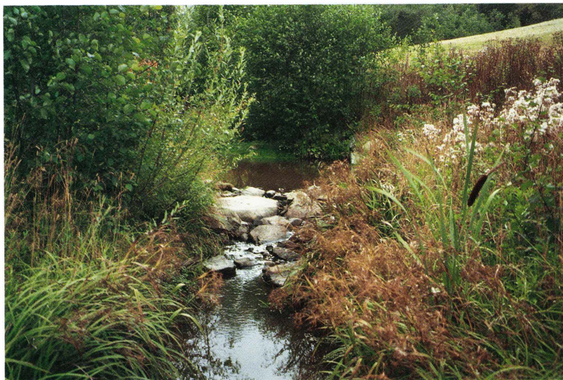
Figur 30: Eksempel på utført terskel av sprengt stein. Rogndalsbekken, Ullensaker, Akershus.
