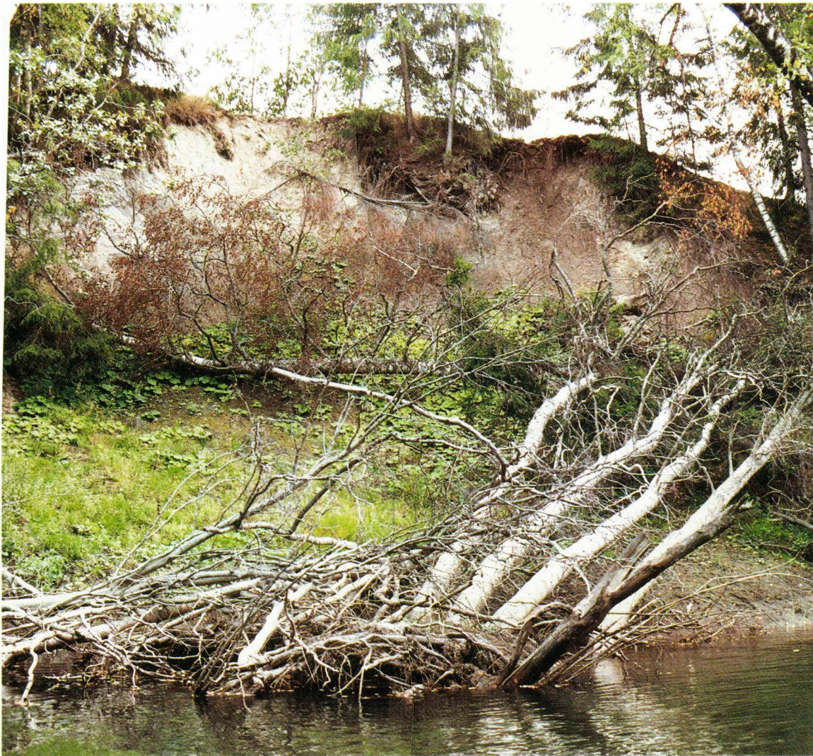
Figur 5: Foto av et skred i en yttersving langs Leiras hovedløp som er forårsaket av undergraving i skråningsfoten.
