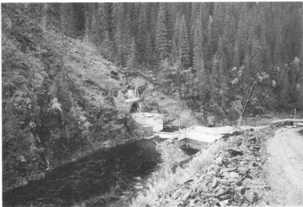
Fig. 12. Høsten 1989 pågikk byggingen av en terskel og overføringstunnel for overføring av Rotla til Nea kraftverk.
