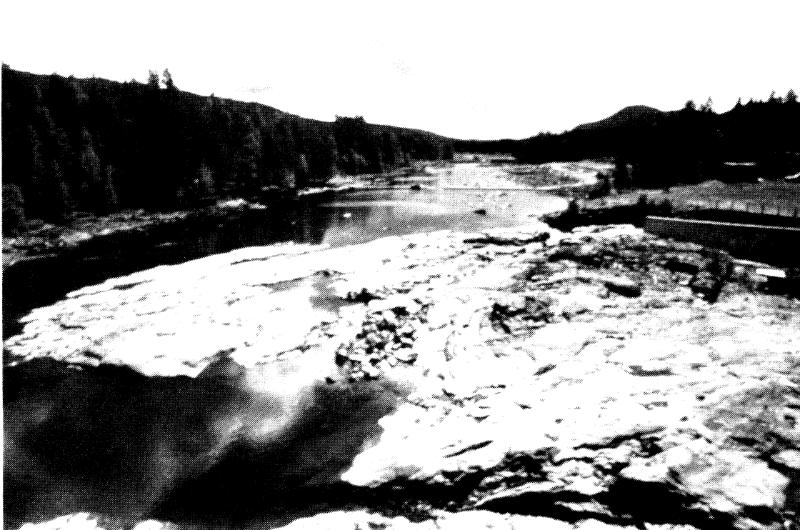
Fig. 1. Pikerfoss kraftverk. 11.07.86. (Foto: K. O. Hillestad).
