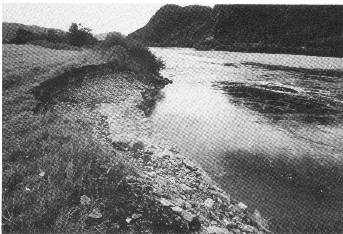
Figur 1. Erosjon i Gaula ved Ler. Er nå forbygget. (Foto: T. O. Sandnæs).
