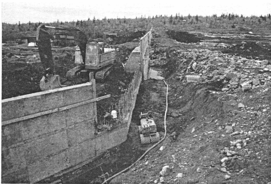
2 Fornyelse av dammen på Våsjøen
