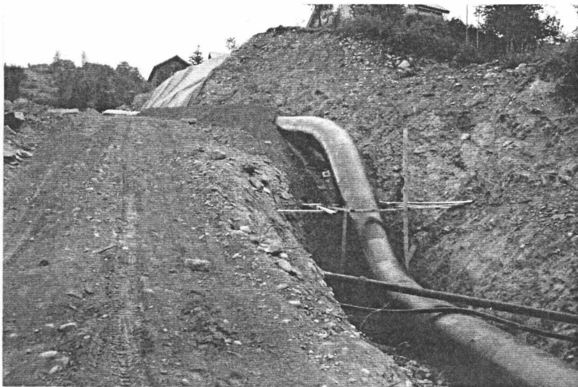
6 Rørgate Utsnitt av stålrøret
