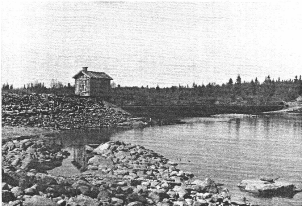
1 Våsjøen dam før ombygging
