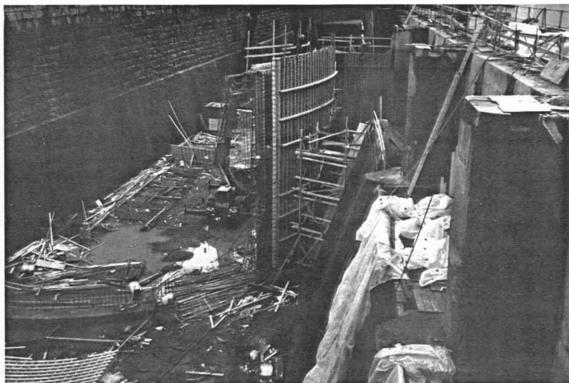
Sperredam under utførelse
