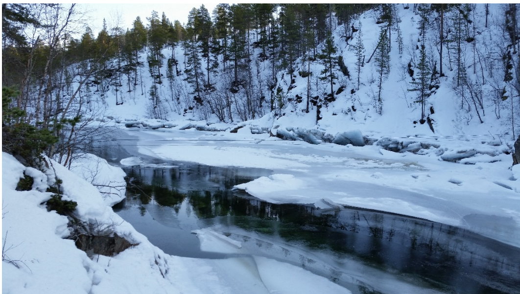
Fig. 1.20 Bestemmende profil for avløpsstasjonen 161.45 Nye Klipa påvirket av is.
