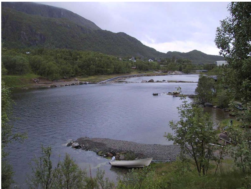
Figur 3.1 viser nedre ende av Nervatnet, med fyllingsdammen i bakgrunnen. Bildet er tatt mot sørvest. Man ser også rørledningen midt i bildet (foto: Blokken skipsverft AS)
